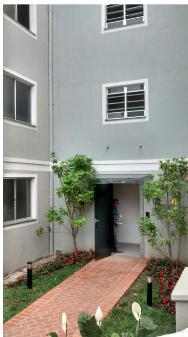
Figura 3 – Edifício no qual foram realizados os estudos (Fonte: os autores)
