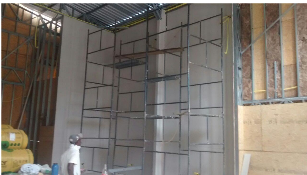
Figura 5: Fechamento interno e lã de rocha
