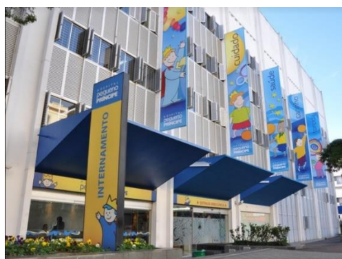
Figura 8 – Fachada do Hospital Pequeno Príncipe
