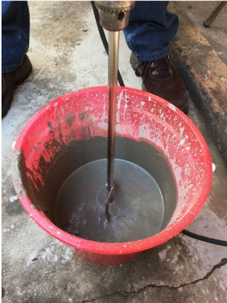
Figura 6. Preparação da argamassa polimérica Fonte: Acervo próprio
