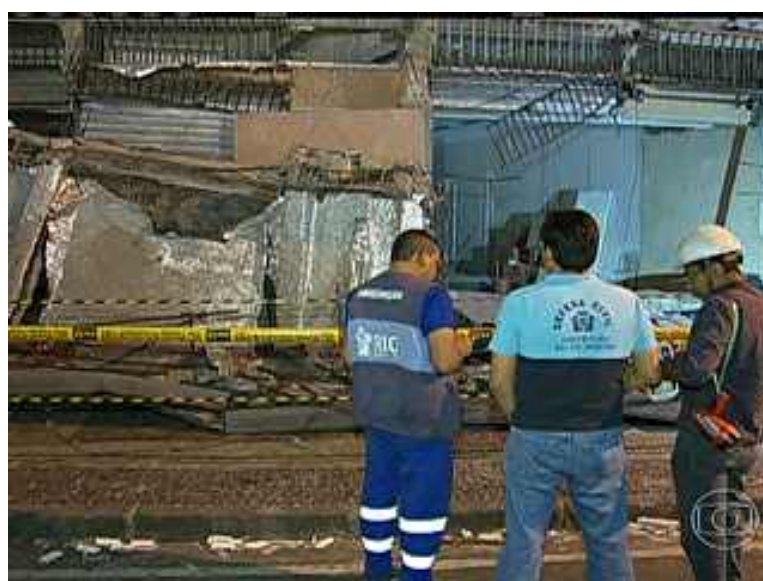
Figura 22. Marquise desabou por falta de manutenção (R7, 2016)
