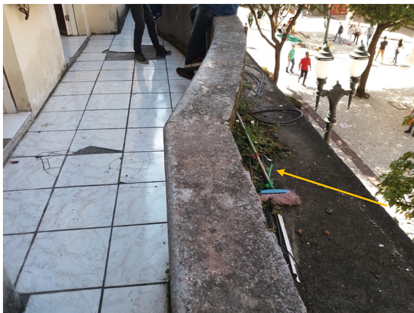
Figura 40. Marquise transformada em sacada (AUTORES, 2018)
