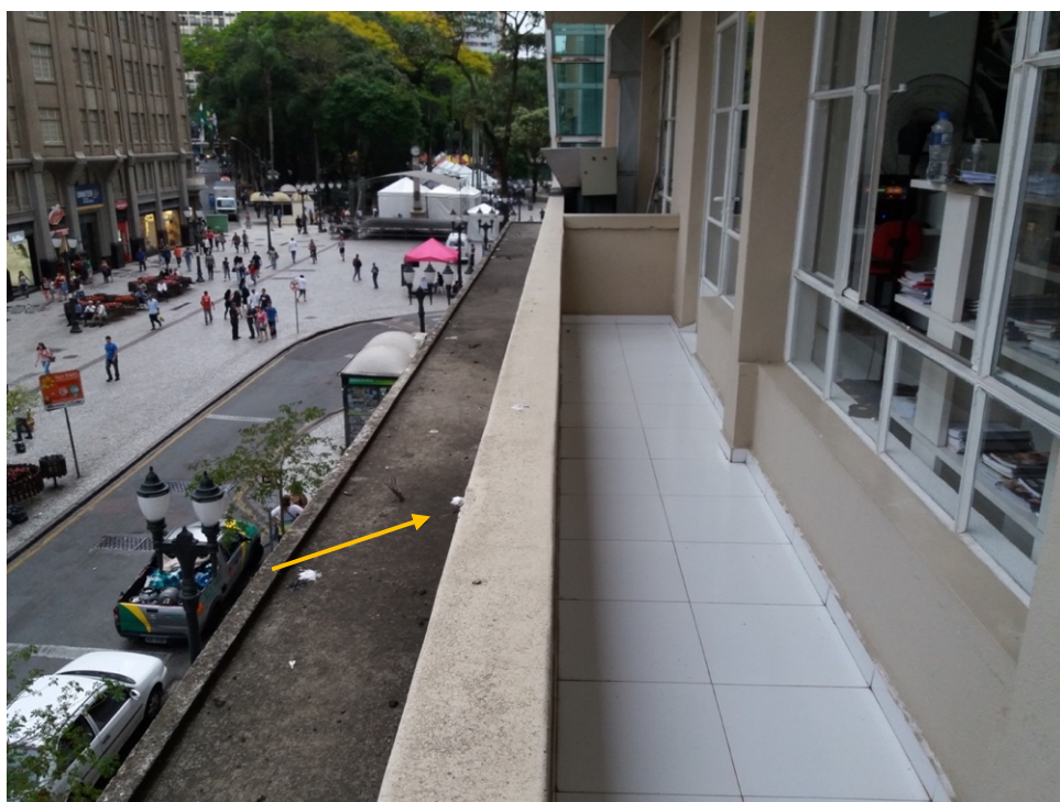
Figura 39. Marquise transformada em sacada (AUTORES, 2018)
