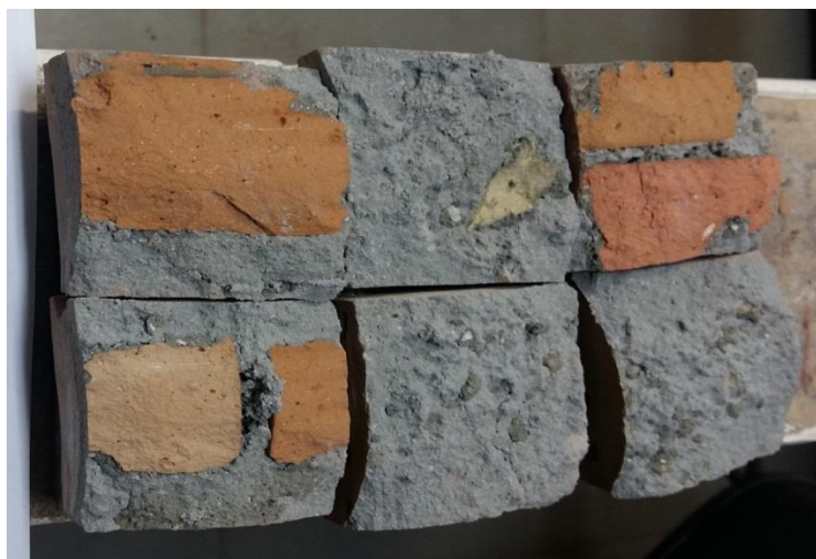
Figura 43: Ensaio 2 - Formas de ruptura dos revestimentos cerâmicos 60x60 cm com o uso da argamassa impermeabilizante Fonte: Autora (2017)
