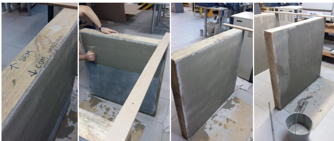
Figura 17: Aplicação das camadas de argamassa impermeabilizante em sentido cruzado Fonte: Autora (2017)
