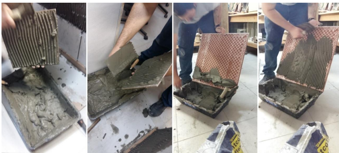
Figura 20: Aplicação da argamassa colante no tardo dos revestimentos - 30x30 cm e 60x60 cm Fonte: Autora (2017)
