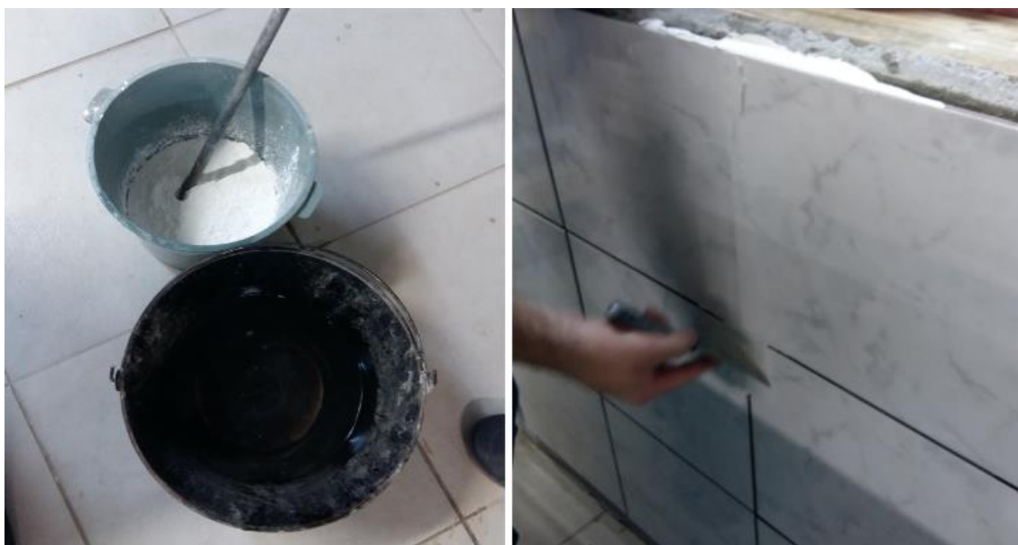
Figura 23: Preparo e aplicação da argamassa de rejuntamento Fonte: Autora (2017)
