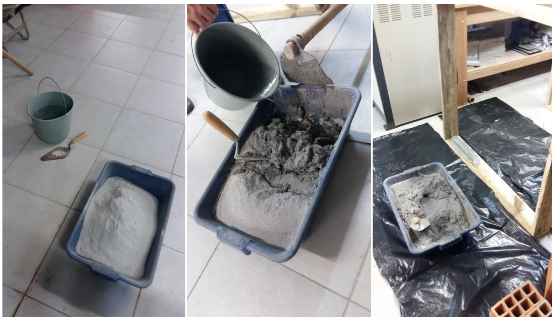
Figura 11: Preparo da argamassa industrializada para assentamento de blocos de alvenaria Fonte: Autora (2017)
