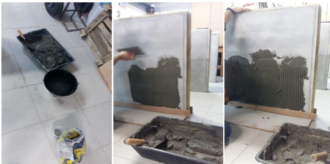
Figura 19: Preparo e aplicação da argamassa colante Fonte: Autora (2017)
