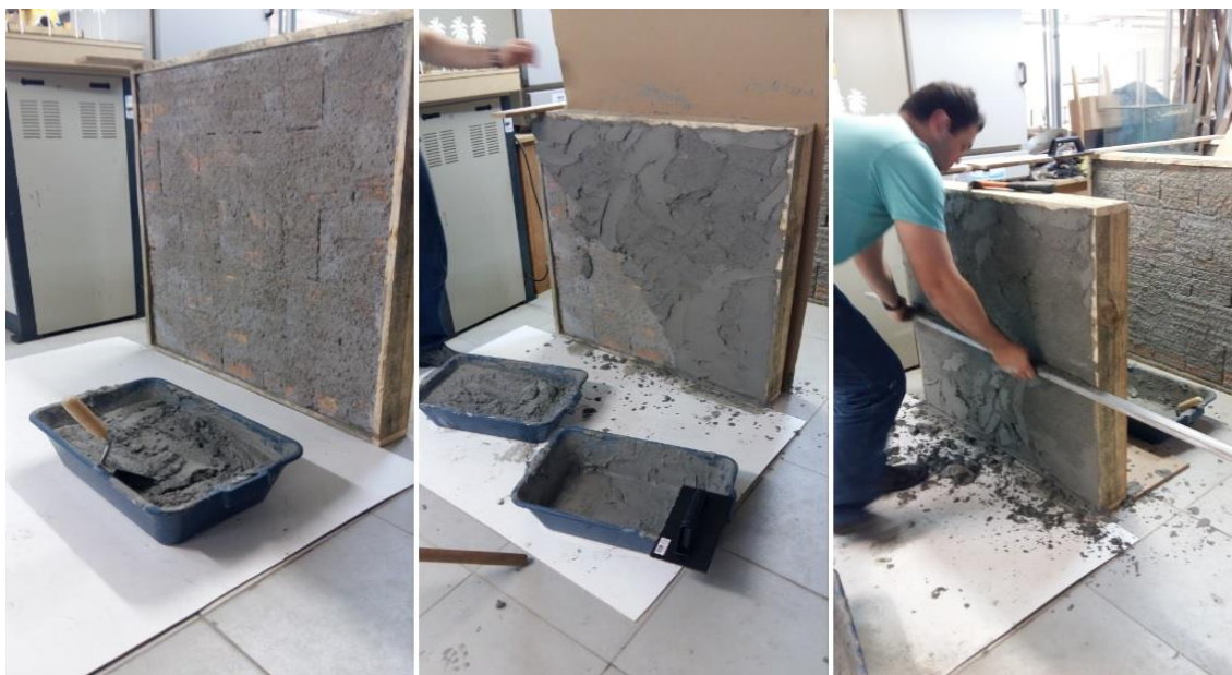
Figura 14: Preparo, aplicação e sarrafeamento da argamassa industrializada (camada única) Fonte: Autora (2017)
