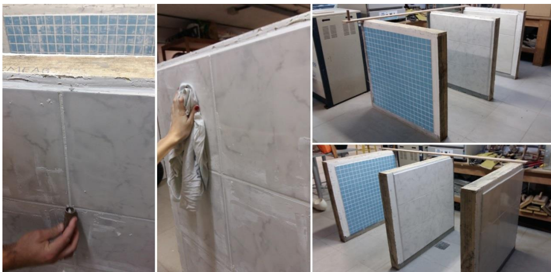
Figura 24: Realização do acabamento do rejunte e da limpeza das paredes testes Fonte: Autora (2017)
