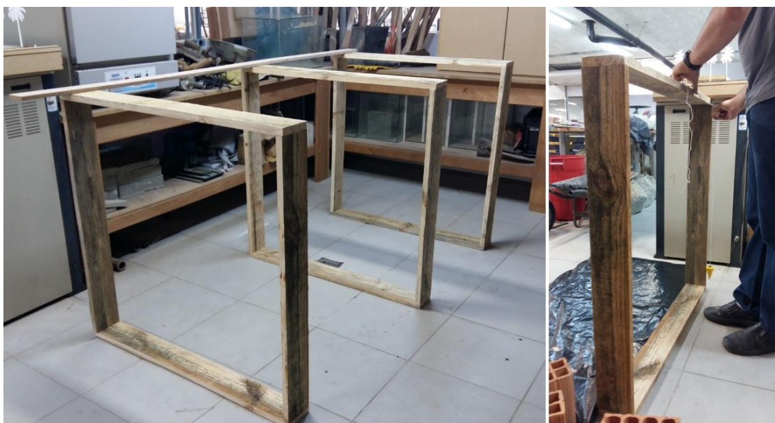
Figura 10: Preparo das molduras de madeira e verificação do prumo Fonte: Autora (2017)
