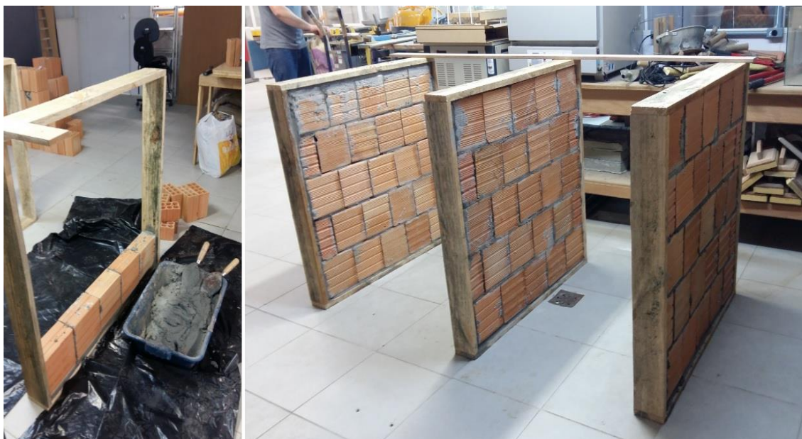
Figura 12: Assentamento dos blocos cerâmicos de vedação Fonte: Autora (2017)
