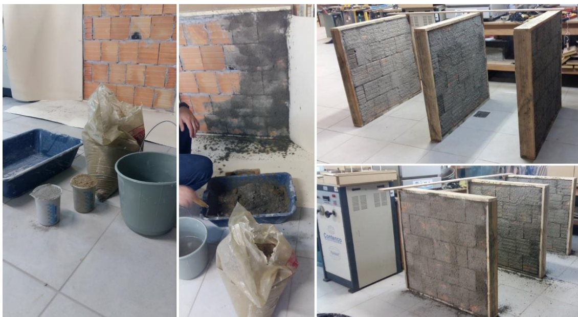
Figura 13: Preparo e aplicação da argamassa de chapisco Fonte: Autora (2017)
