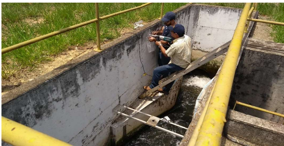
Figura 30 – Extração na estrutura de saída do efluente tratado
