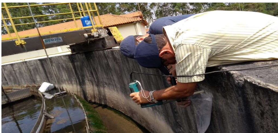
Figura 28 – Extração do 2º centímetro da amostra coletada do Decantador
