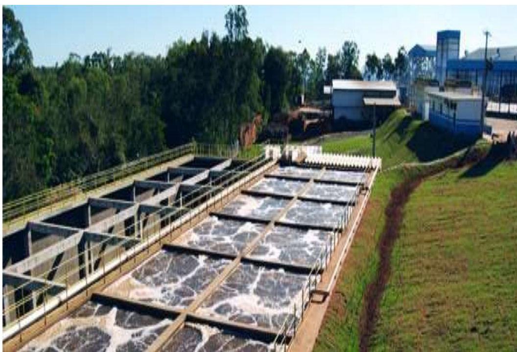
Figura 4 – Tanque de aeração de uma ETE Fonte: http://www.comafrango.com.br (2013)
