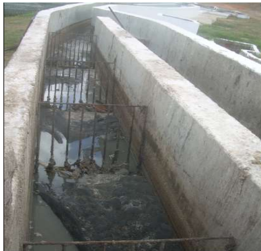
Figura 2 - Gradeamento de uma ETE
