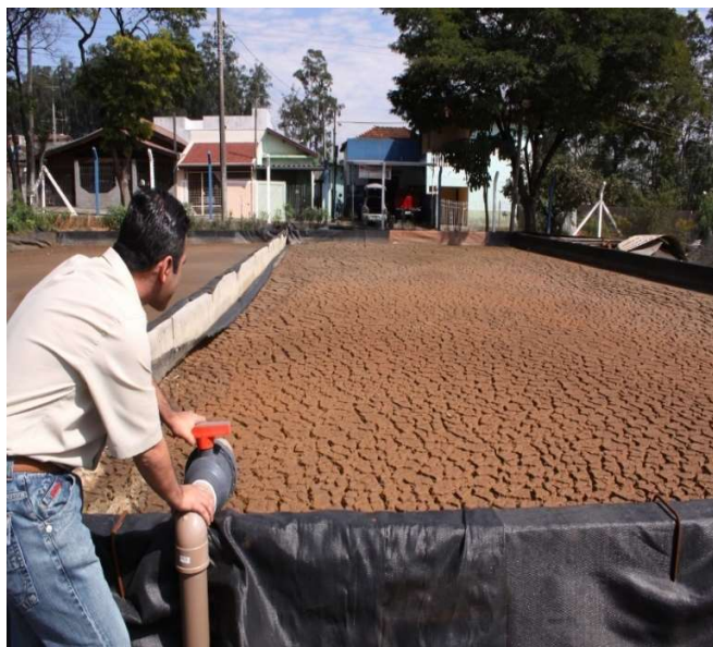
Figura 6 – Secagem e tratamento de lodo de uma ETE.
