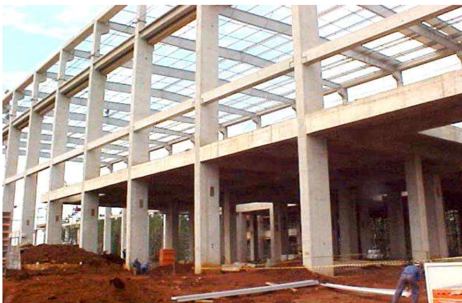
Figura 9 – Estrutura em concreto armado
