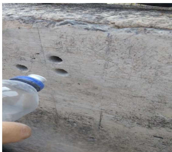
Figura 22 – Soprador adaptado
