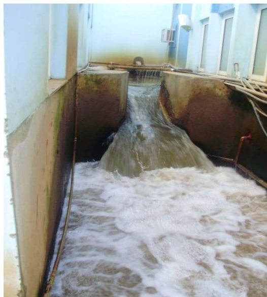
Figura 7 – Saída do efluente tratado (Calha Parshall).
