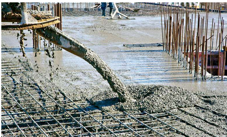
Figura 8 – Concreto sendo lançado em uma estrutura
