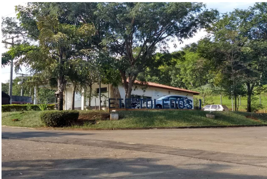
Figura 13 – Prédio Operacional ETE Toledos
