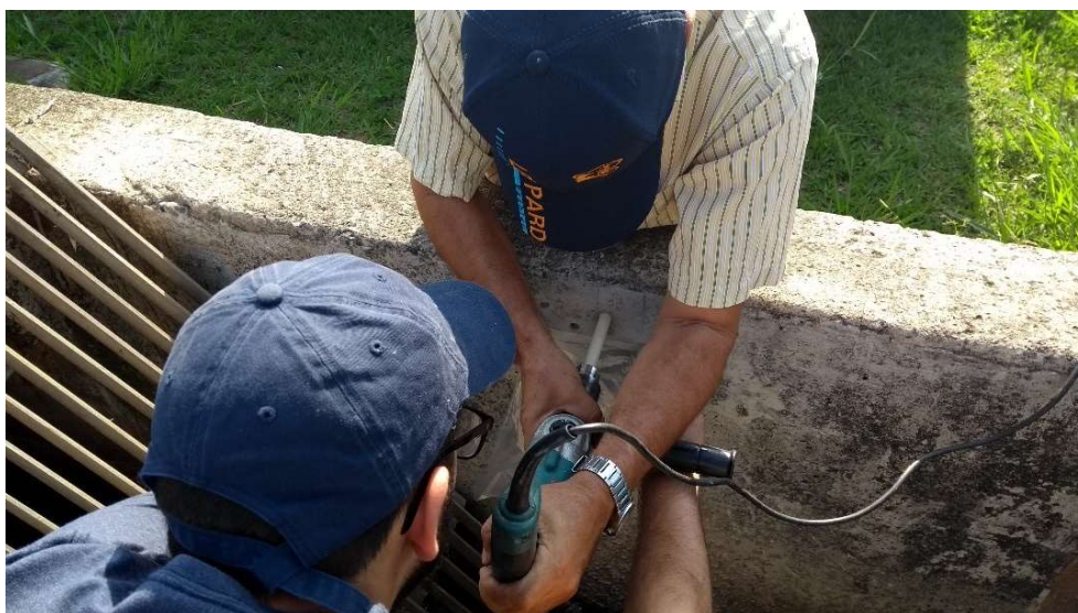
Figura 24 – Extração do 1º centímetro da amostra
