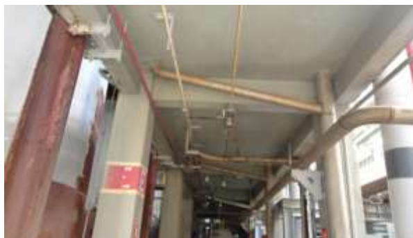
Imagem 43: Vista da segunda laje
