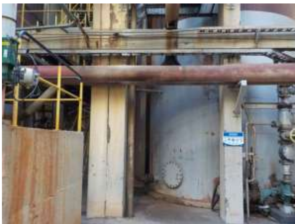
Imagem 2: Pilares separado por junta lado oeste do prédio
