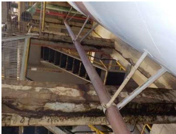
Imagem 16: Vigas dos três pavimentos.
