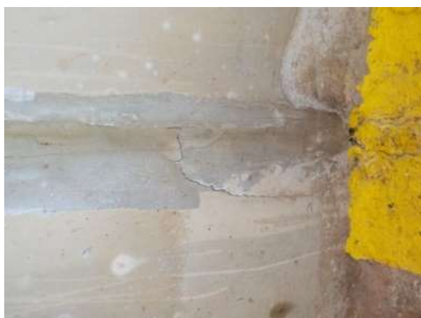
Imagem 39: Junta em pilar.
