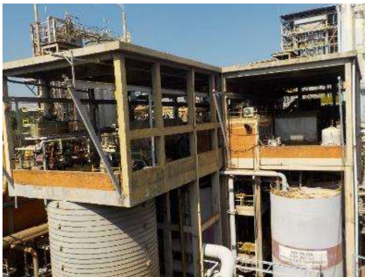
Figura 15: Vista da frente do prédio
