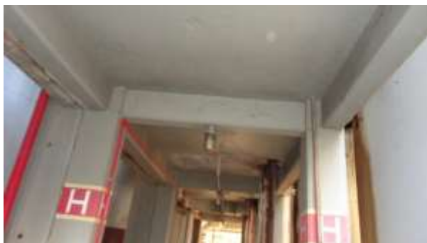
Imagem 61: Corredor pavimento térreo.
