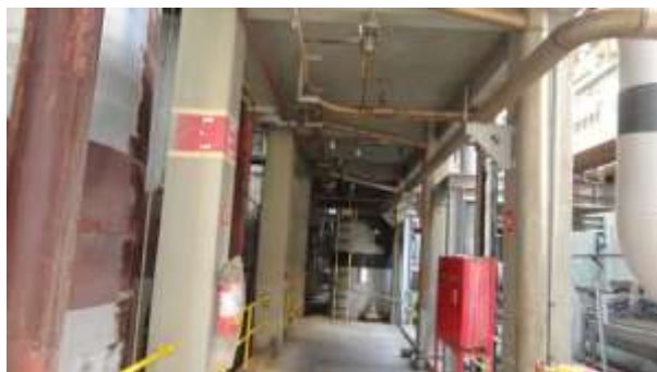
Imagem 42: Corredor da segunda laje.
