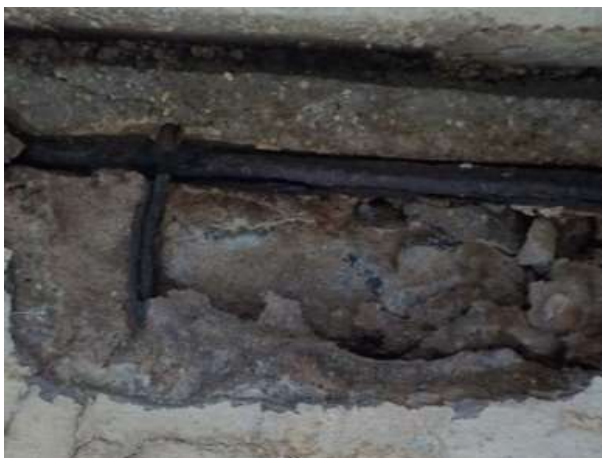
Imagem 21: Estribo rompido
