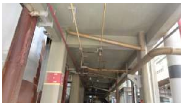
Imagem 6: Laje do 2º pavimento com pontos que estão em boas condições
