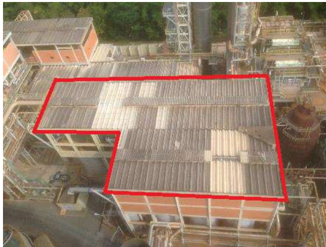
Figura 14: Vista de cima do prédio
