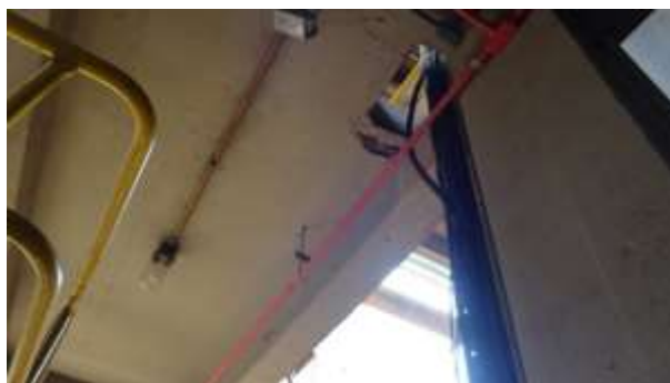
Imagem 44: Laje primeiro pavimento
