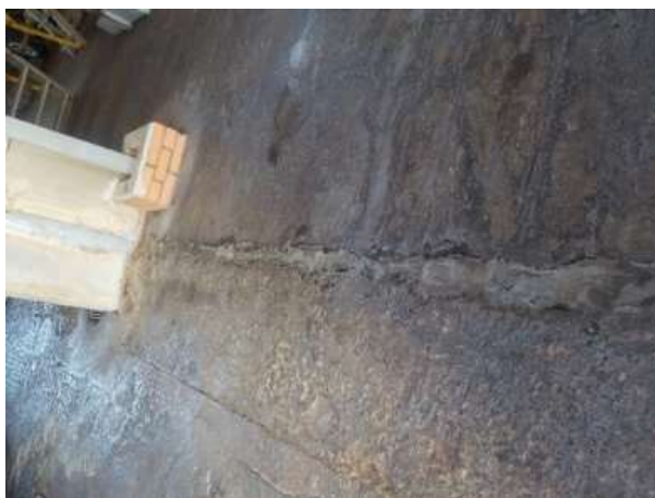
Imagem 30: Junta no 3º pavimento.
