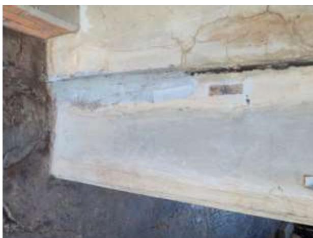
Imagem 3: Junta dos pilares pavimento Térreo
