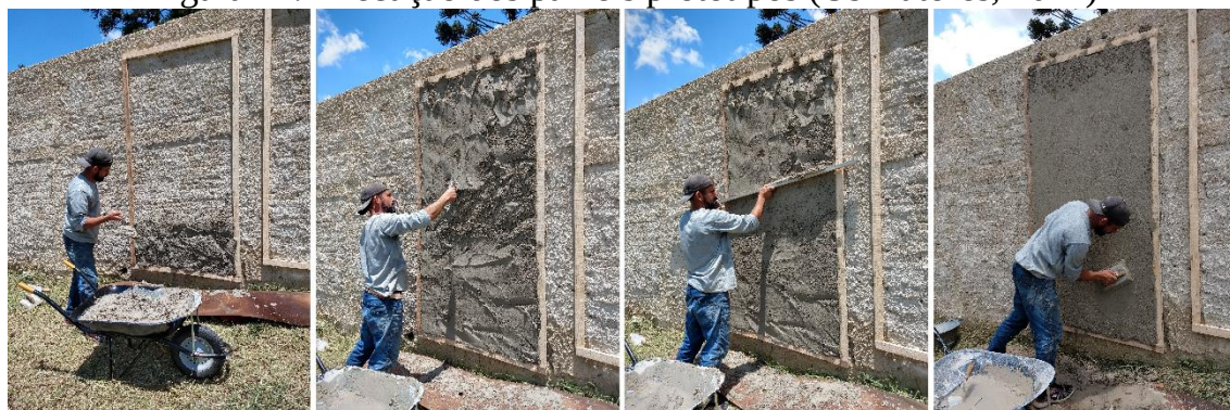
Figura 11. Execução dos painéis protótipos (Os Autores, 2021)
