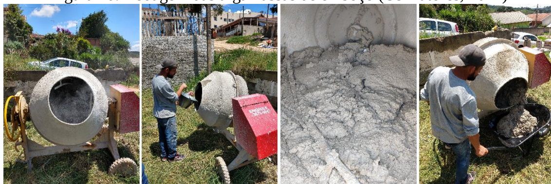
Figura 10. Rodagem das argamassas de emboço (Os Autores, 2021)
