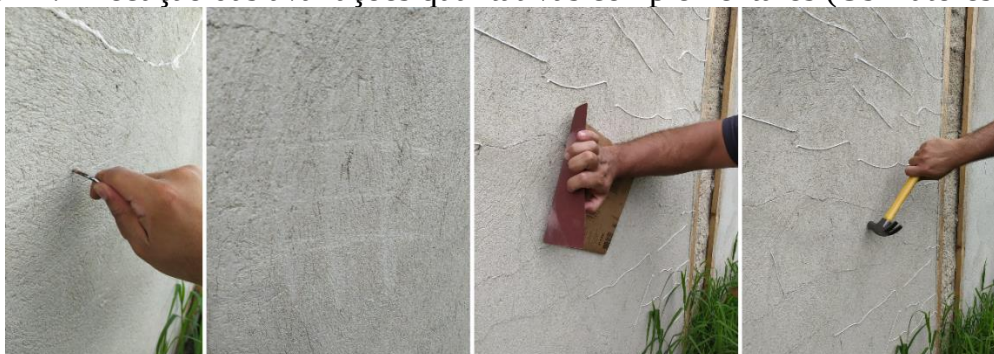
Figura 21. Execução das avaliações qualitativas complementares (Os Autores, 2021)
