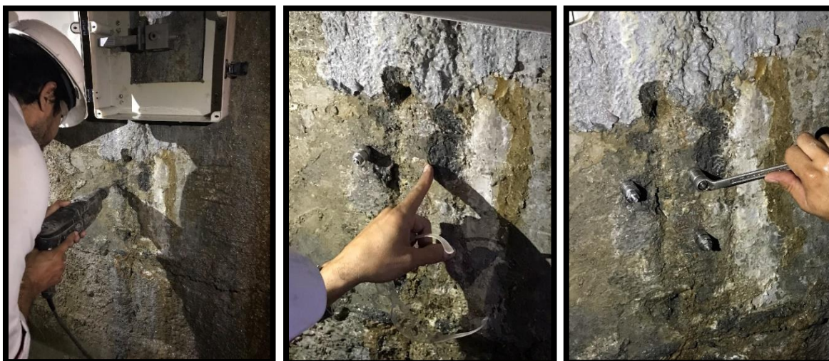
Figura 10 – Instalação dos pinos de aço Fonte: Autor (2018).
