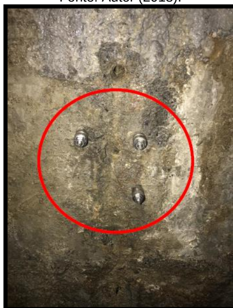
Figura 11 – Pinos instalados na junta de contração. Fonte: Autor (2018).
