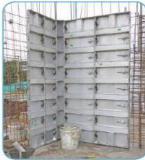
Figura 5. Fechamento das formas com pino e cunha
