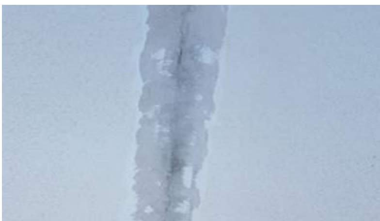
Figura 29. Parede fissurada na linha das faquetas
