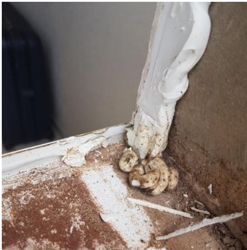
Figura 18. Poliuretano aplicado nas esquadrias para vedação
