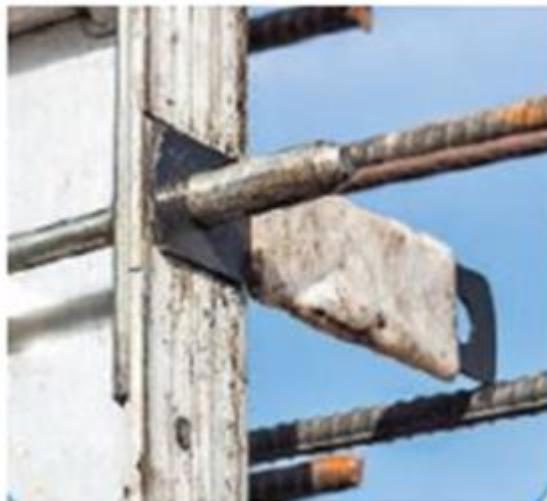
Figura 7. Fechamento da parte interna com a parte externa e faquetas
