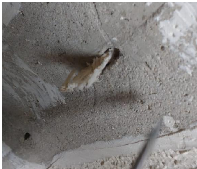
Figura 32. Orifício das faquetas com isomanta
