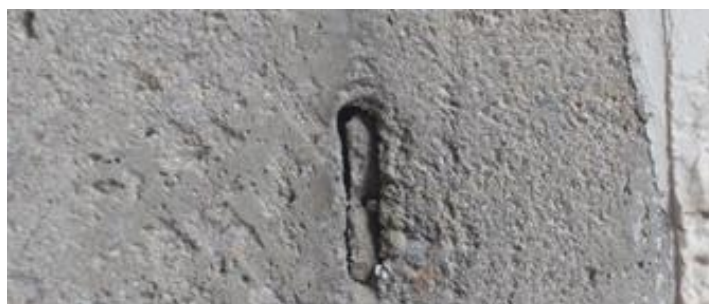
Figura 31. Argamassa solta dentro do orifício da faqueta
