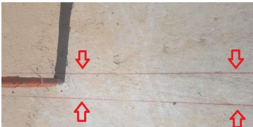
Figura 3. Marcação do traçado da parede
