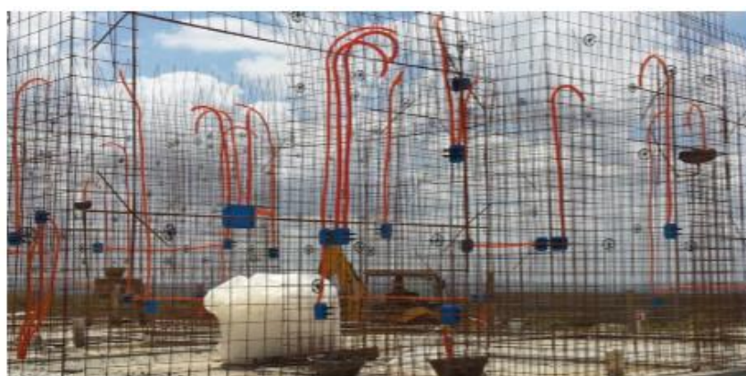
Figura 4. Montagem de telas soldadas com instalações elétricas e espaçadores
