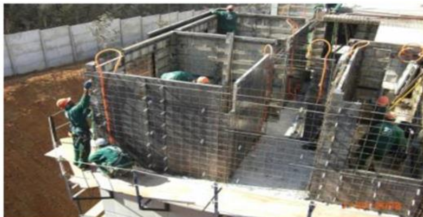
Figura 6. Fechamento de todo o pavimento
