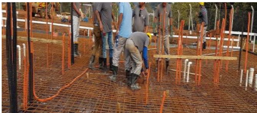
Figura 24. Exemplo de eletrodutos passando por meio das armaduras
