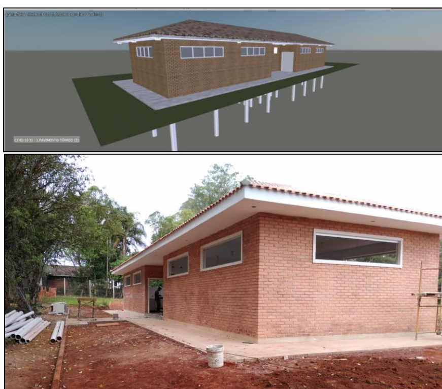
Figura 51: Planejado x Execução dia 01/11/2018 (Autor, 2018)
