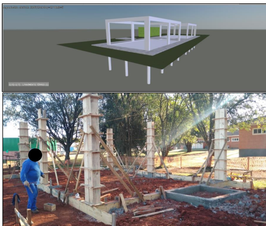
Figura 50: Planejado x Execução dia 23/07/2018 (Autor, 2018)
