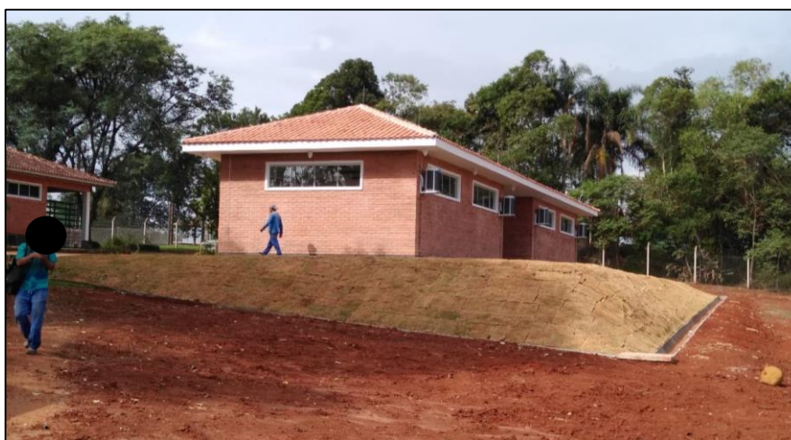
Figura 53: Obra finalizada em 03/12/2018 (Autor, 2018)
