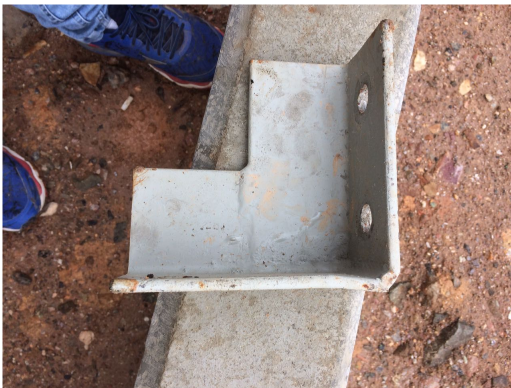
Figura 22– Adaptação com suportes metálicos para apoio dos painéis dos pré-moldados.
