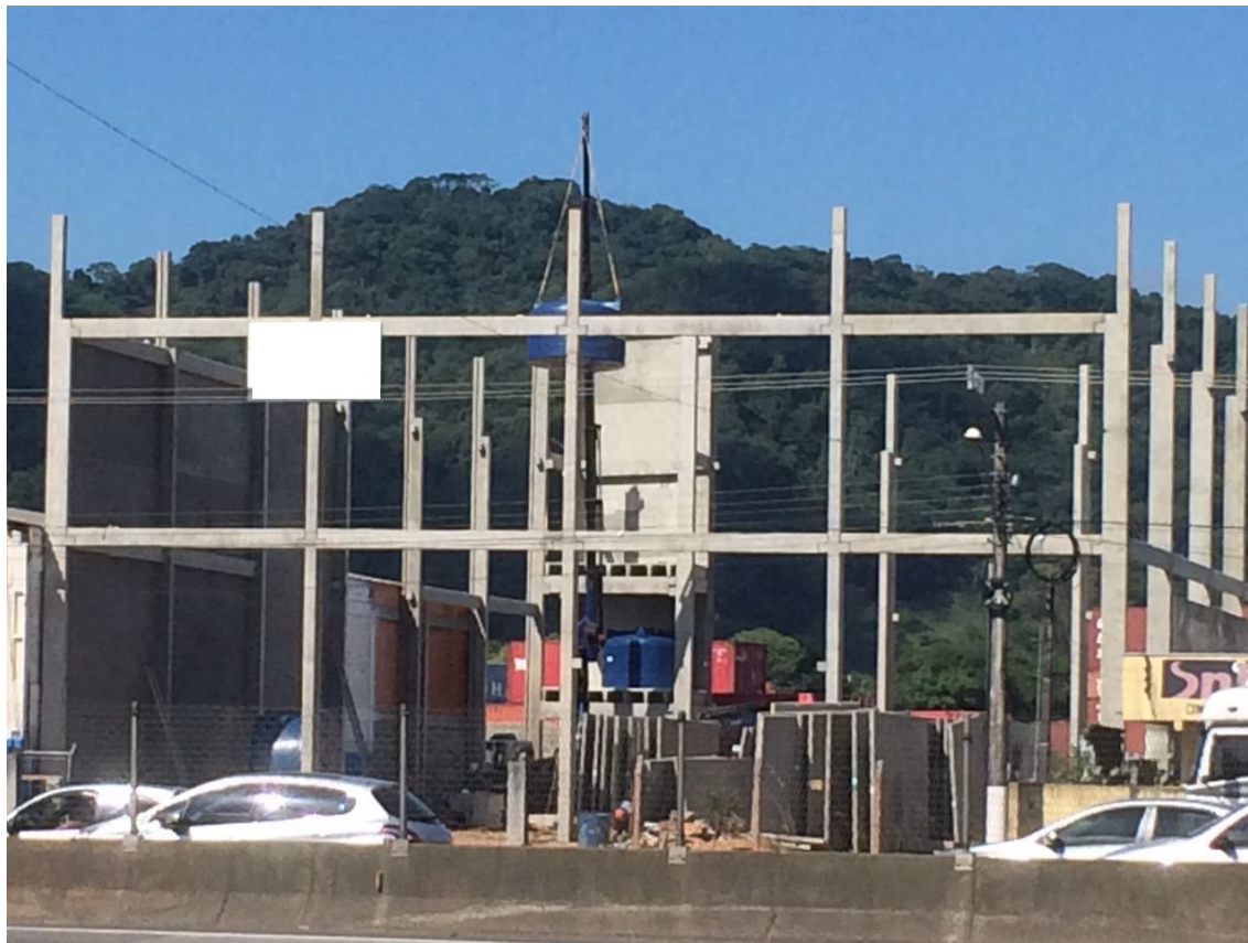
Figura 9- Vista geral da obra.
