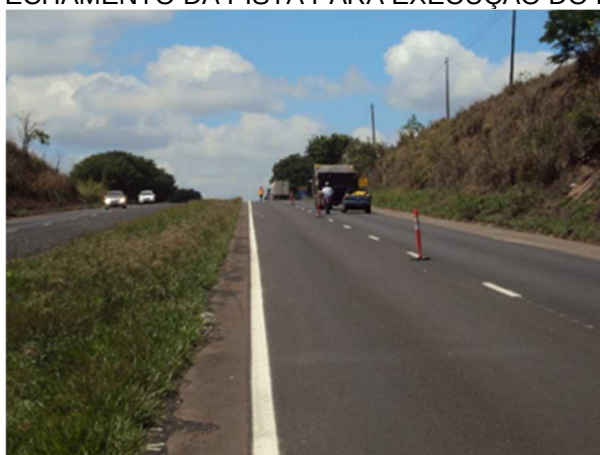
FIGURA 25 – FECHAMENTO DA PISTA PARA EXECUÇÃO DO LEVANTAMENTO
