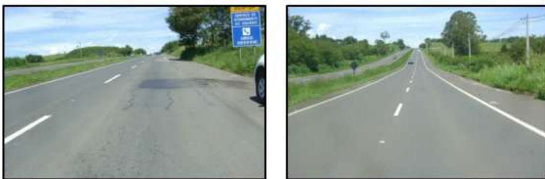
FIGURA 21 – FOTOGRAFIA DO KM 176,160 AO KM 175,720
