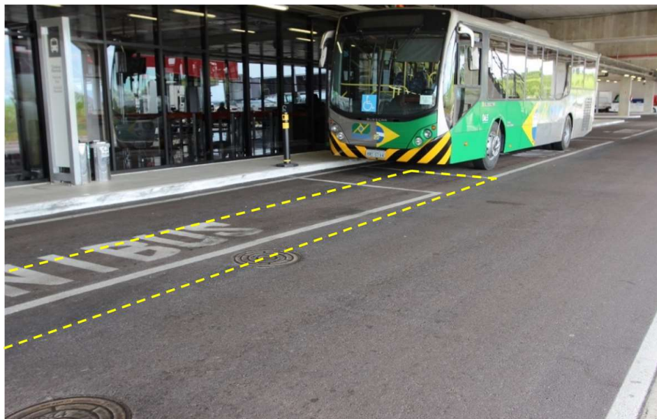
FIGURA 42 – TRILHA DE RODA NA SEÇÃO FLEXS 202 NA FAIXA DE ESTACIONAMENTO DE ÔNIBUS.
