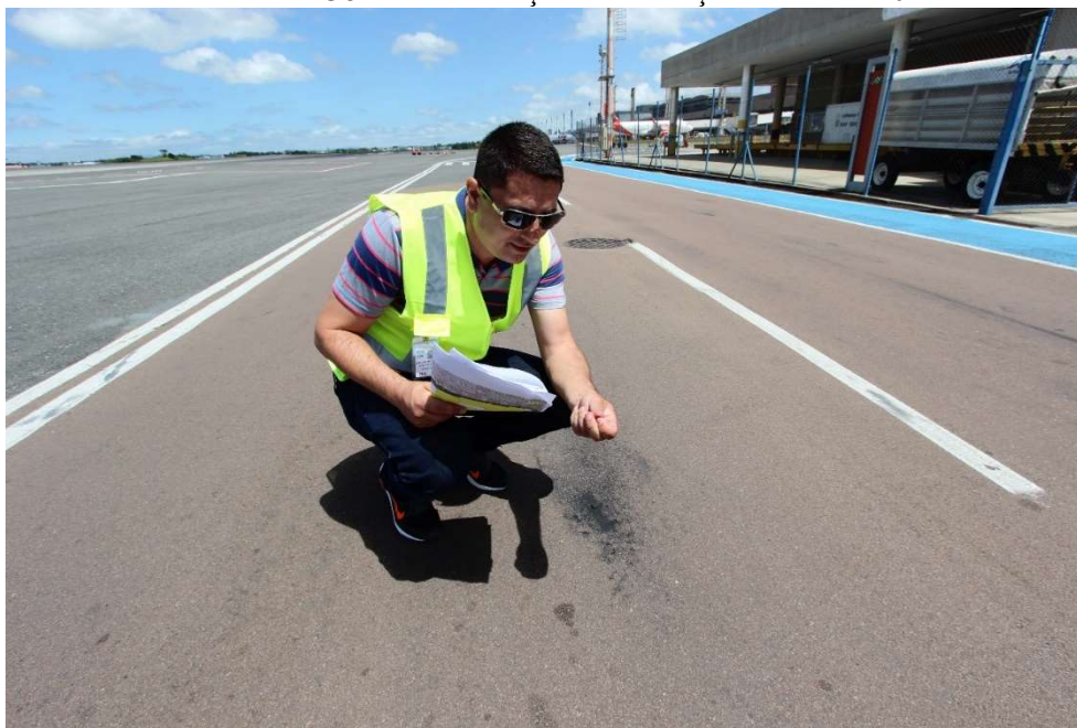
FIGURA 38 – EXSUDAÇÃO NA SEÇÃO FLEXS 104.
