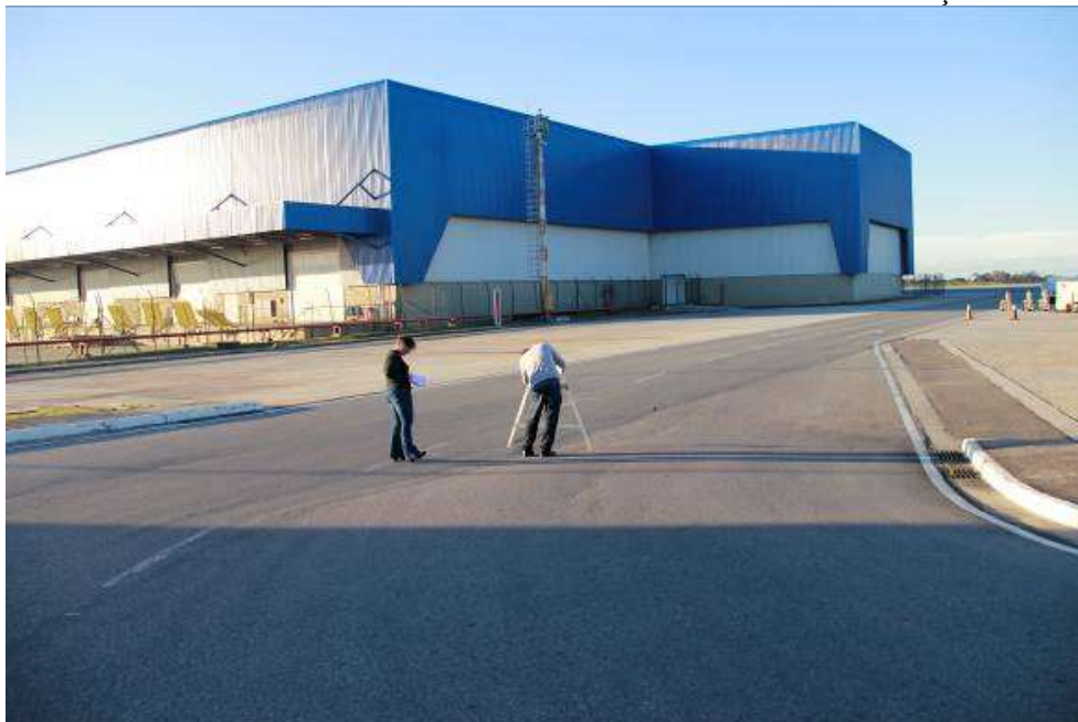
FIGURA 25 – SUBTRECHO FLEXS 103 DA VIA DE SERVIÇO 01
