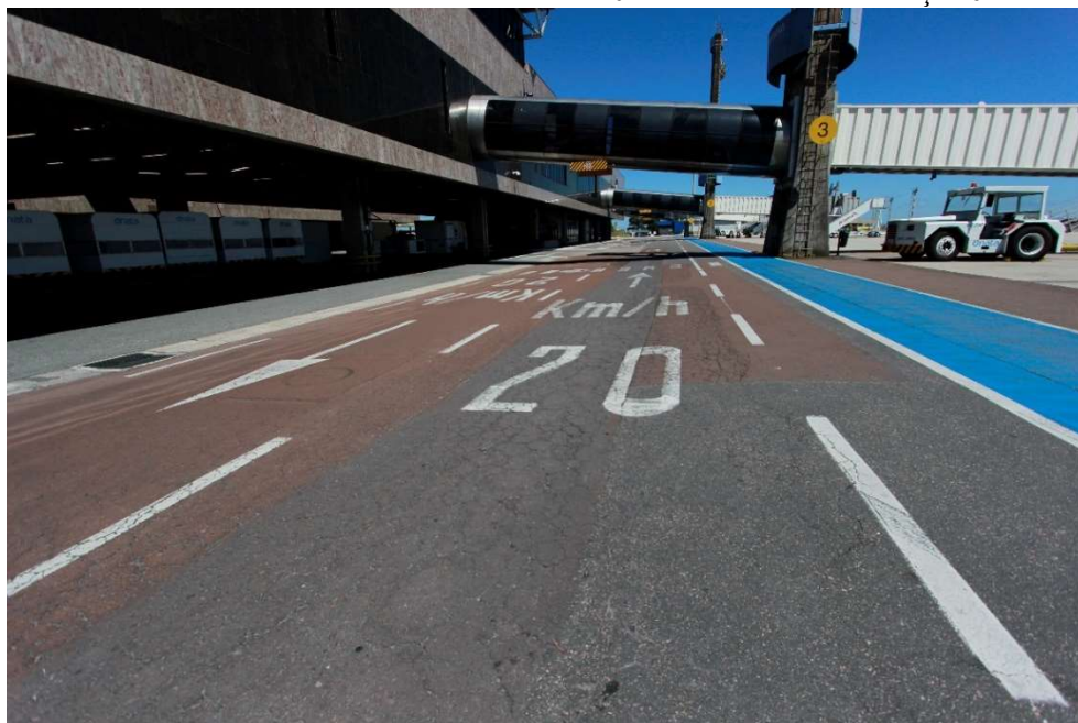
FIGURA 24 – SUBTRECHO FLEXS 102 DA VIA DE SERVIÇO 01
