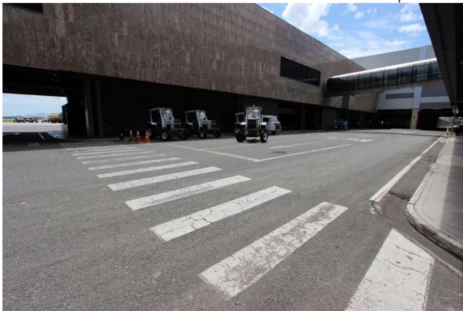
FIGURA 41 – TRINCA EM BLOCO E ENVELHECIMENTO NA SEÇÃO FLEXS 201.
