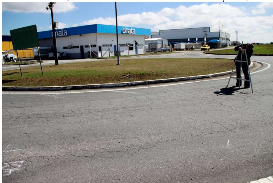
FIGURA 51 – TRILHA DE RODA INTERNA NA SEÇÃO 401
