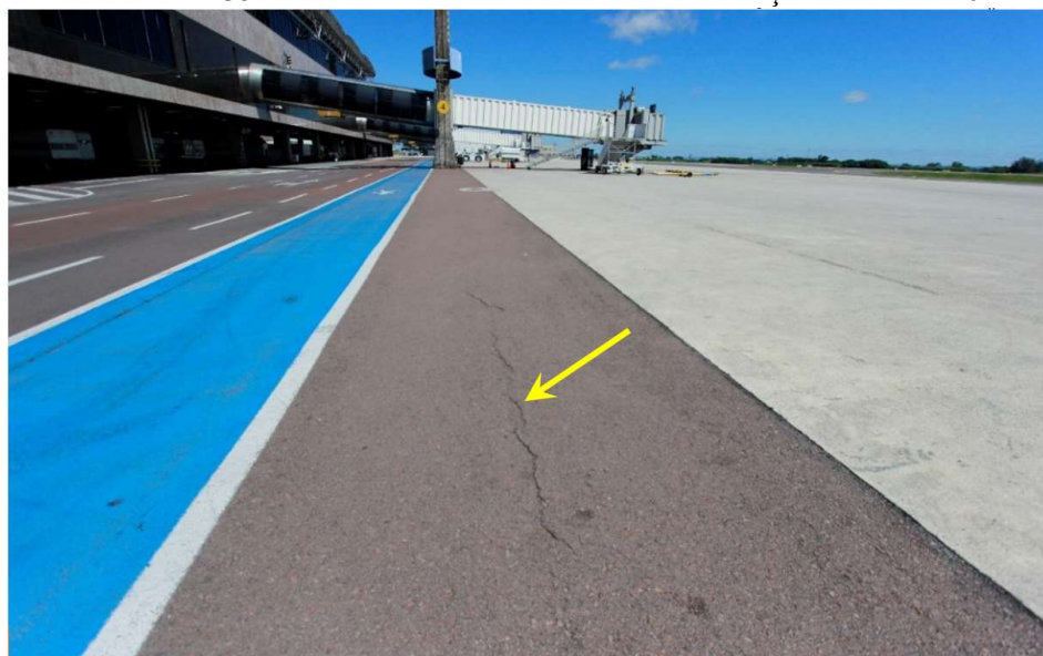
FIGURA 35 – TRINCA LONGITUDINAL NA SEÇÃO FLEXS 102
