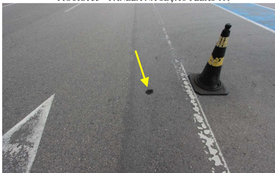
FIGURA 33 – PANELA NA SEÇÃO FLEXS 101
