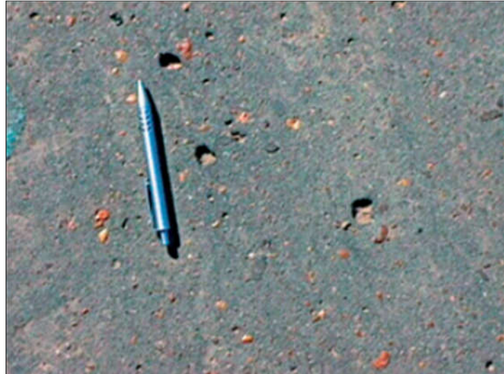
FIGURA 12 - DESGASTE
