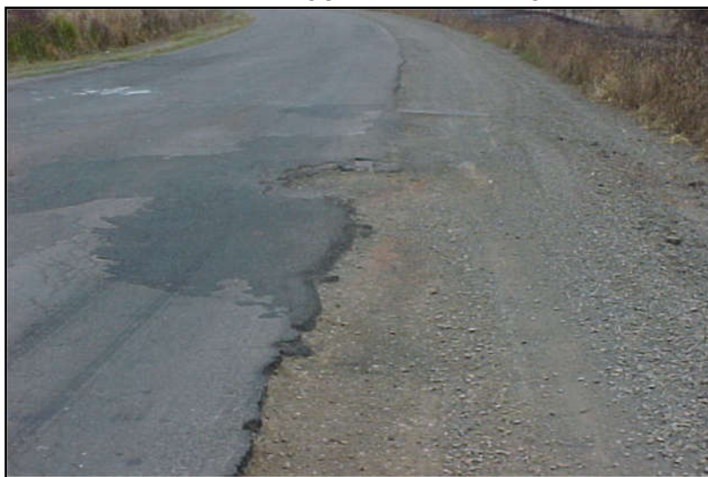
FIGURA 14 - REMENDO
