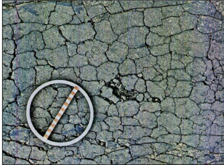
FIGURA 4 – TRINCAS INTERLIGADAS
