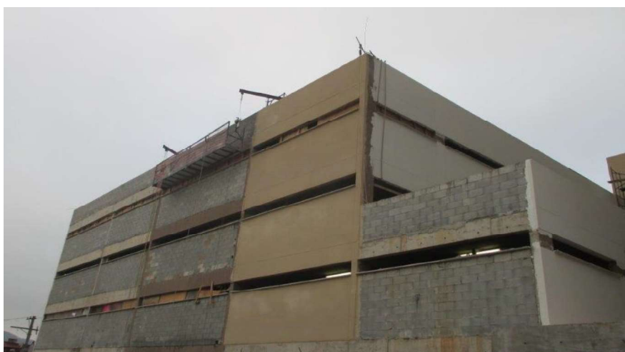
Fotografia 2. Chapisco rolado e revestimento monocamada em empreendimento habitacional (Os autores, 2019)
