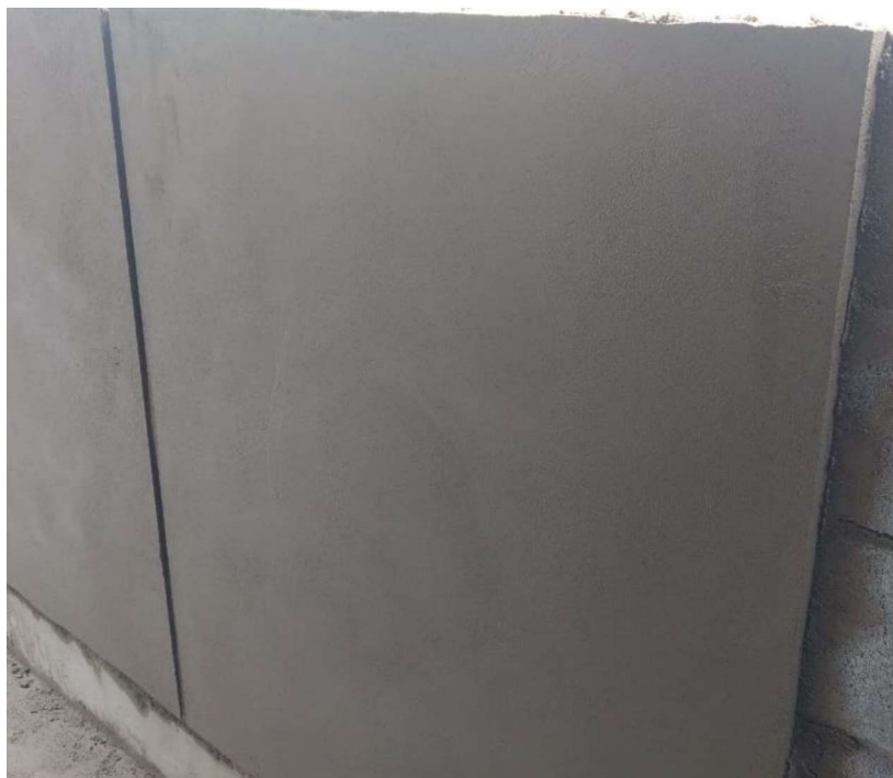
Fotografia 11. Revestimento argamassado monocamada (Os Autores, 2019)
