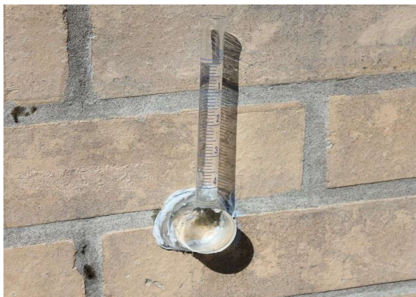
Figura 7. Aplicação do método do Tubo de Karsten em sistema de vedação vertical (Pereira, 2015)
