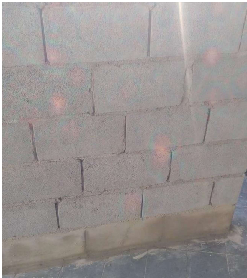
Fotografia 6. Impermeabilização da primeira fiada no pano base (Os Autores, 2019)
