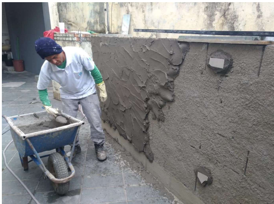
Fotografia 7. Aplicação da camada de emboço em argamassa industrializada (Os Autores, 2019)
