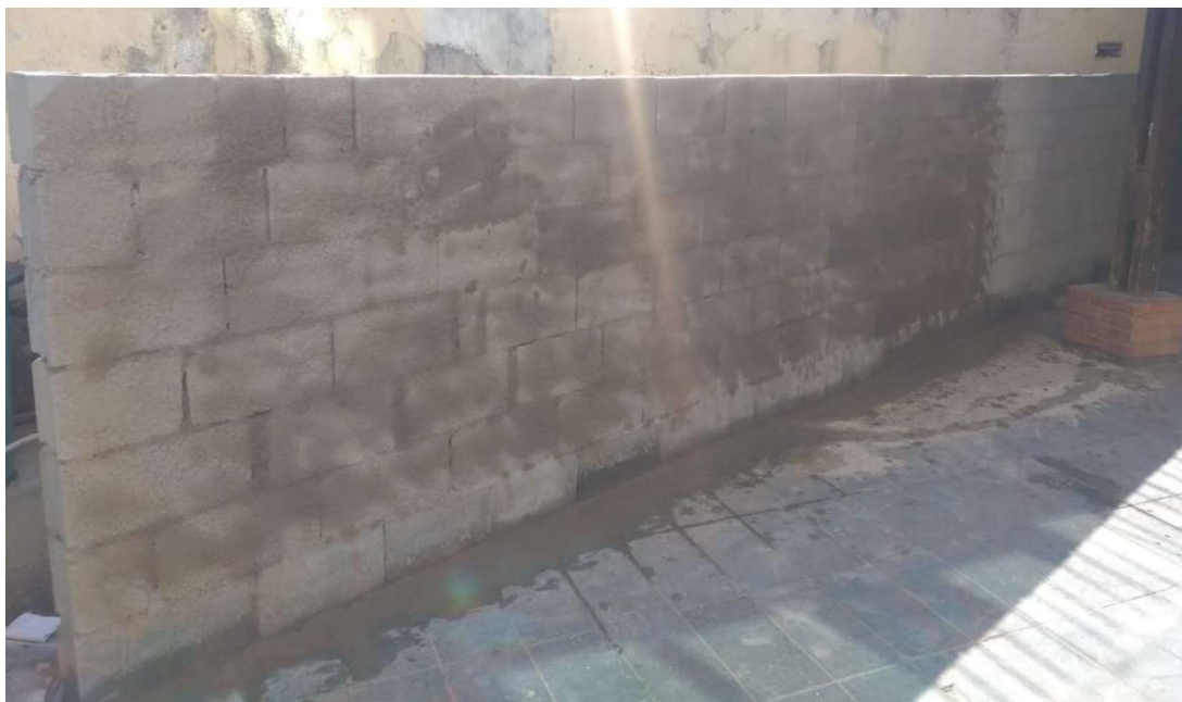
Fotografia 4. Chapisco na alvenaria (Os Autores, 2019)
