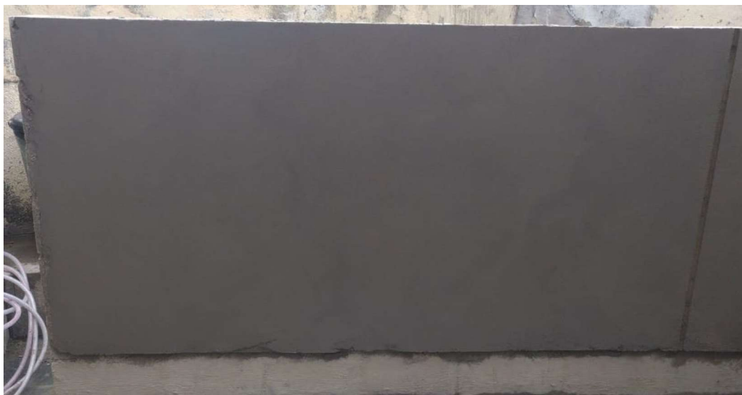
Fotografia 9. Revestimento argamassado industrializado (Os Autores, 2019)
