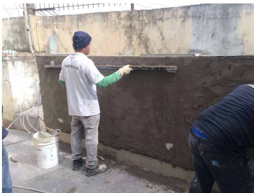
Fotografia 8. Regularização da camada de emboço (Os Autores, 2019)
