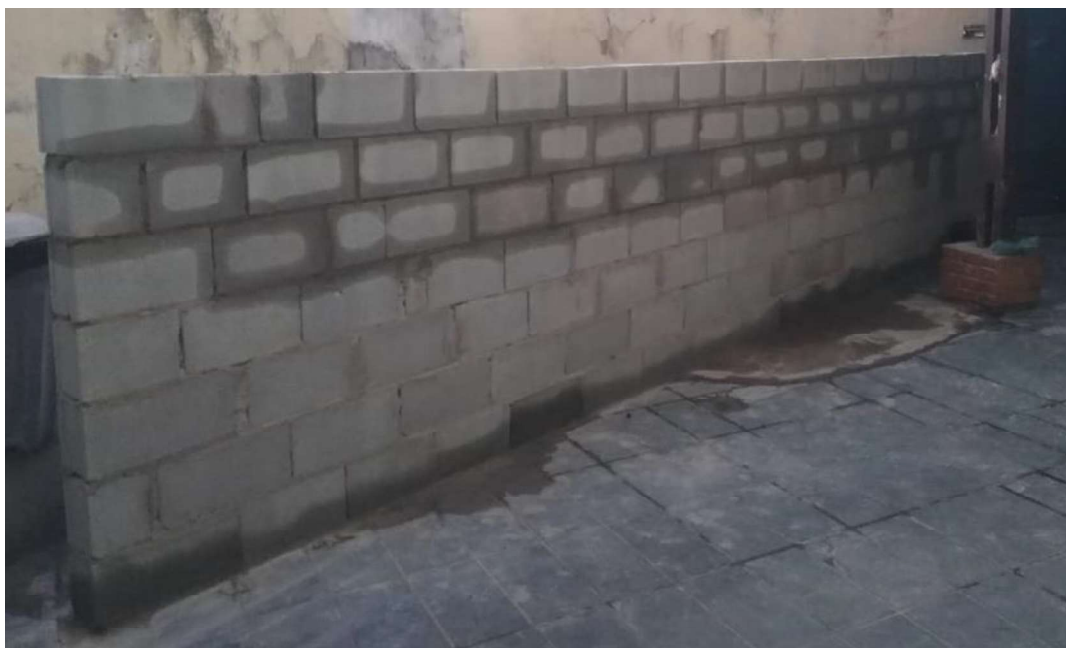
Fotografia 3. Alvenaria em blocos de concreto (Os Autores, 2019)
