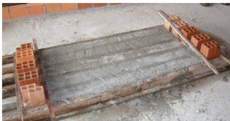
FIGURA 6 – Vergas pré-moldadas na obra (UNAMA, 2009).
