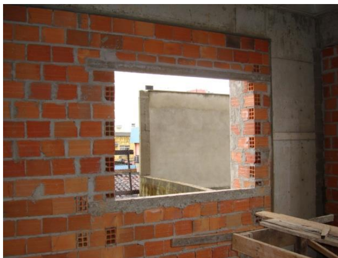
FIGURA 7 – Instalação de vergas pré-moldadas na obra (UNAMA, 2009).
