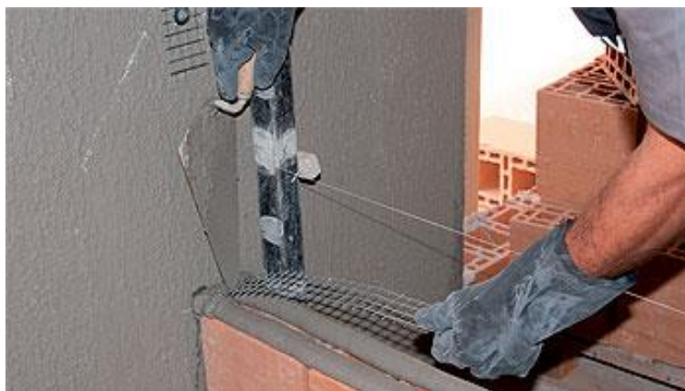
Figura 30 – Fixação de tela entre estrutura e alvenaria (Construção mercado, 2018)
