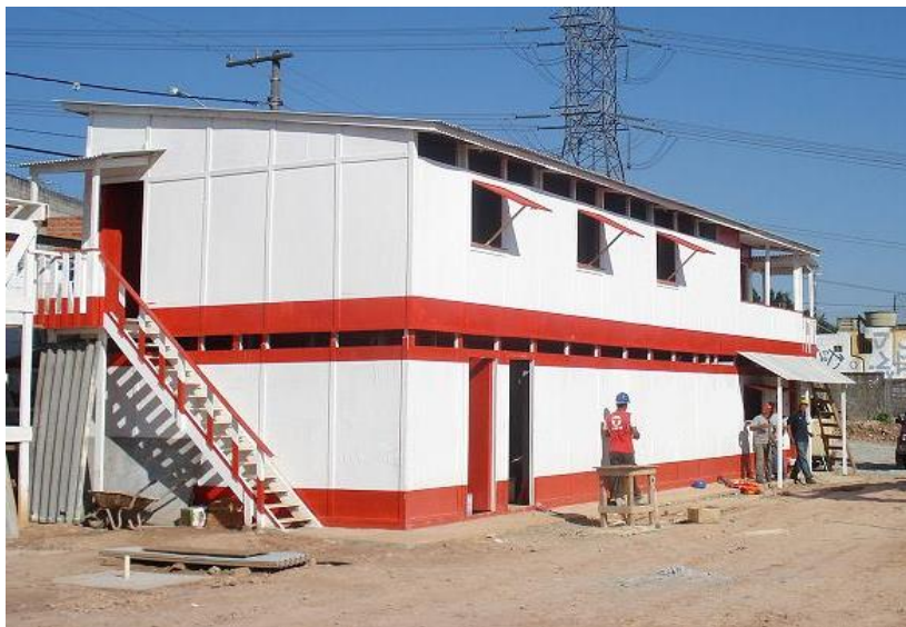
Figura 11 – Canteiro de obras em madeira (RONARTEJANDIRA, 2011).
