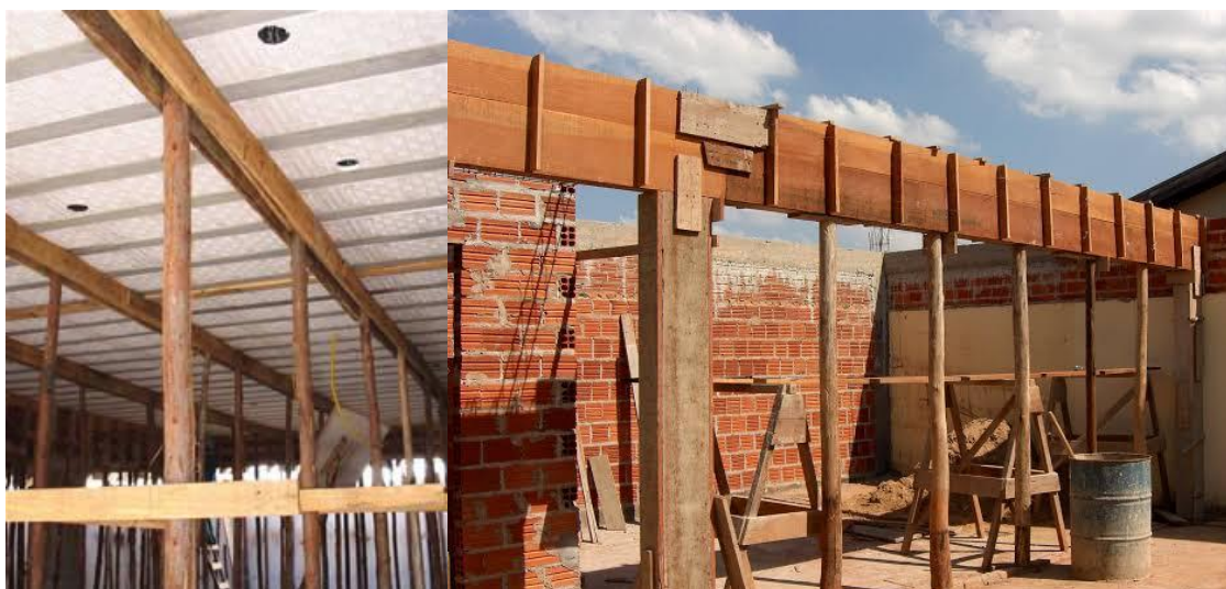
Figura 17 – Execução de Lajes (FONTE: Acervo pessoal, 2017)
