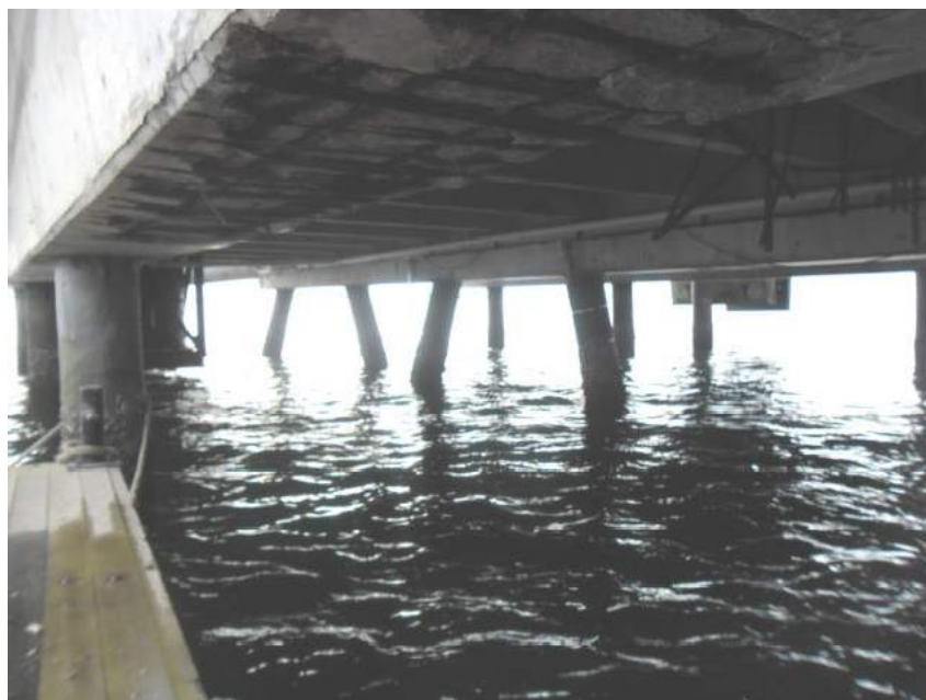
Figura 14. Parte inferior do píer, vigas transversais e longitudinais, vigas transversais.
