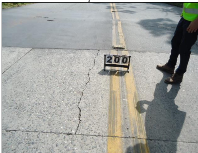
FIGURA 4 – ALÇAMENTO DE PLACAS
