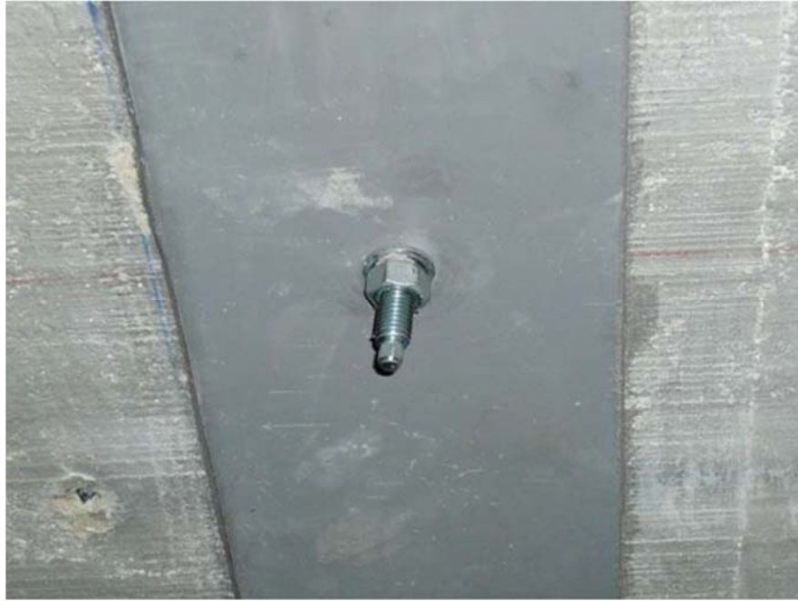
Figura 3 – Detalhe na colocação de buchas expansivas no reforço de uma laje (HTECNIC, 2016).
