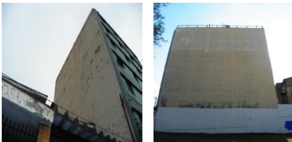
Figura 8- Vista geral da fachada lateral esquerda e direita
