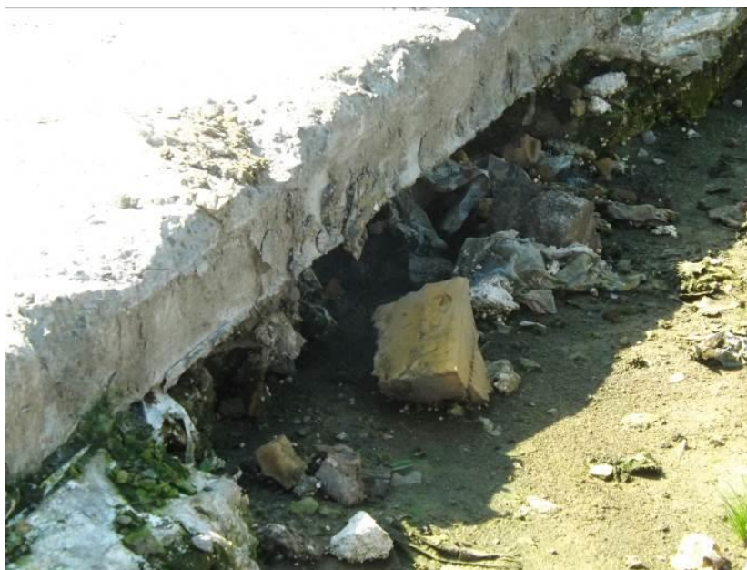
Foto 11: Detalhe do sistema de isolamento de isopor degradado.
