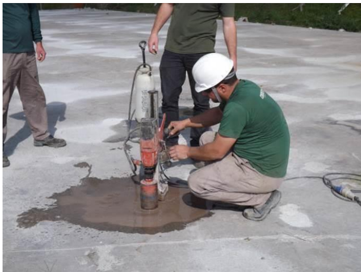
Fotos 16A: Extração dos corpos de prova.
