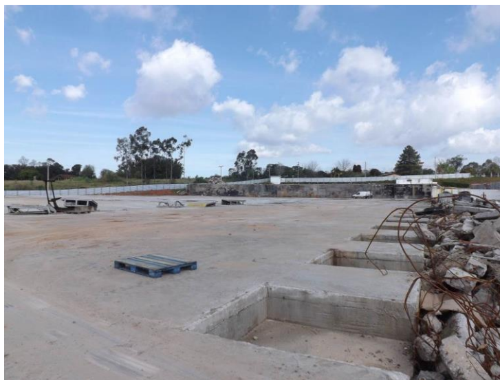
Foto 04: Vista do piso após o incêndio e operação de rescaldo
