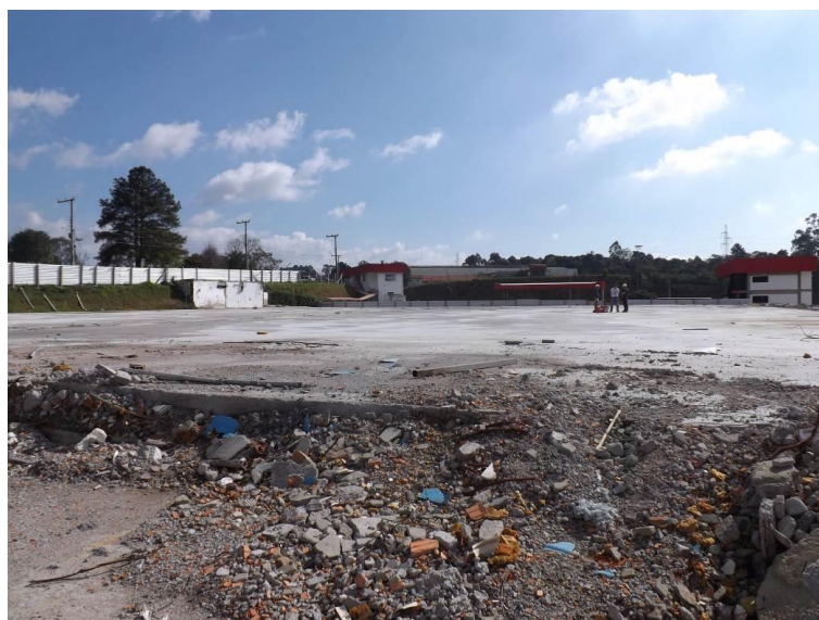
Foto 03: Escombros após o sinistro
