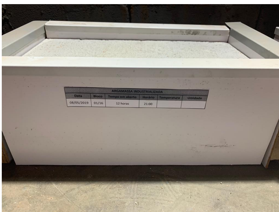
Figura 9 Forma executada para garantir a espessura correta de argamassa
