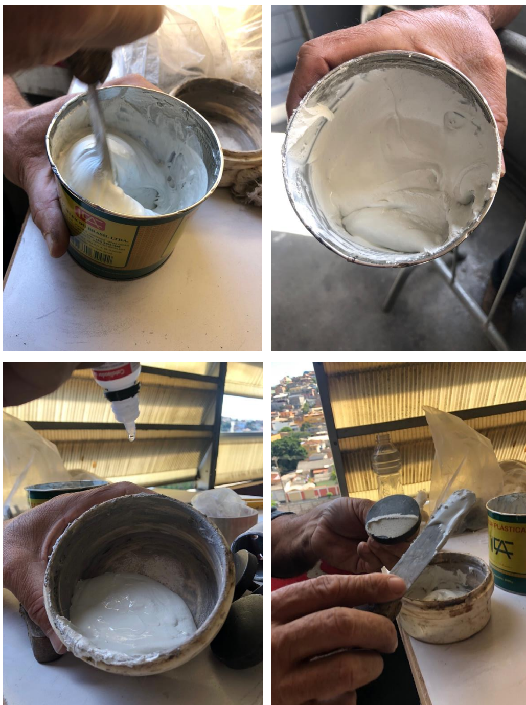
Figura 37 Mistura do adesivo colante
