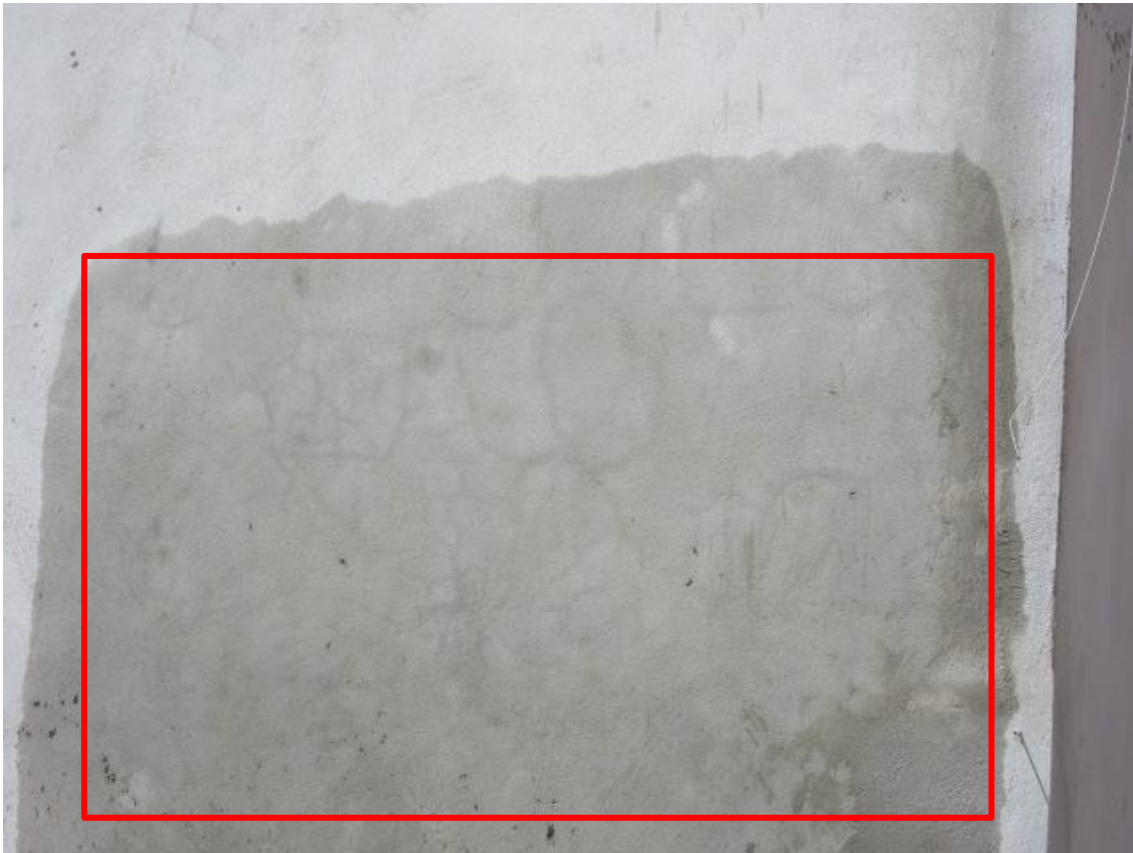
Figura 1 Fissura Mapeada
