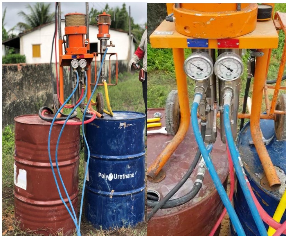
Figura 25 – Bomba injetora bi-componente MC –I 700 e tambores com resinas de Poliuretano.
