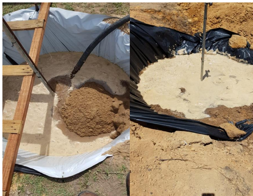
Figura 23 – Preenchimento do tubulão com solo arenoso e adensamento hidráulico.
