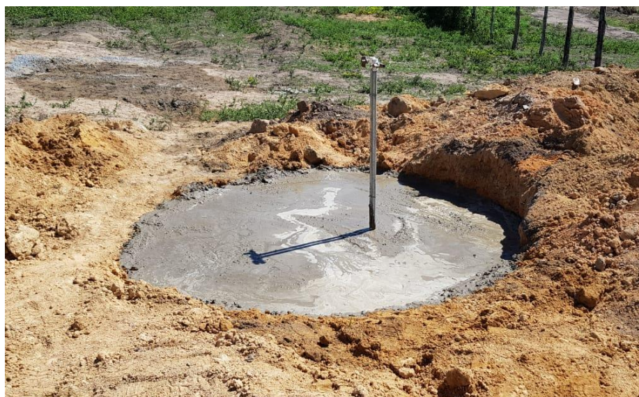
Figura 24 – Laje de concreto com espessura de 20cm para confinamento do material, simulando uma sapata rasa.
