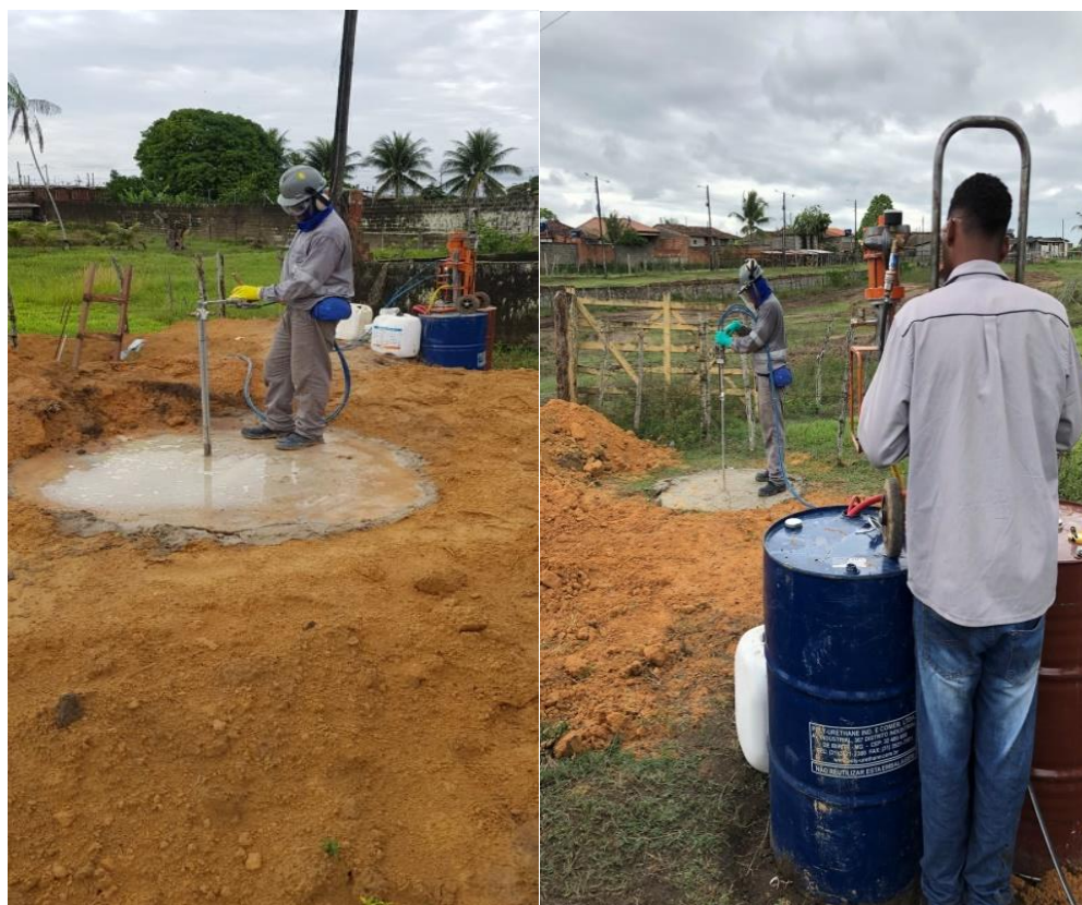
Figura 26 – Mostra injeção de resina de poliuretano (PU) em solo arenoso
