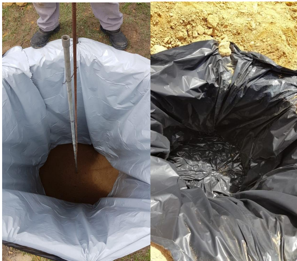
Figura 21 – Tubulão escavado e sendo preenchido com solo arenoso.
