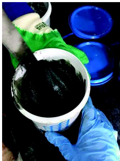
Foto 23 – Mistura dos bi componentes da ponte de aderência.
