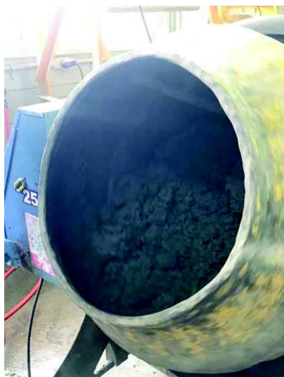
Foto 7 – Mistura do concreto na betoneira estacionária.
