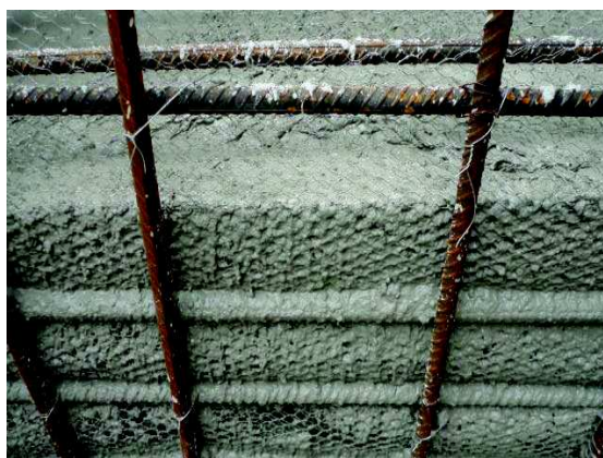
Figura 2 – Detalhe do funcionamento de tela de aço galvanizado durante a concretagem: pouca fuga de nata (Britez et al. 2013).
