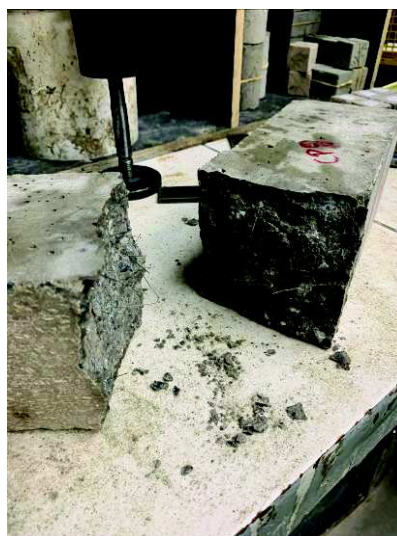
Foto 43 – CP-8 – série de corpos de prova com junta a 90° com ponte de aderência.
