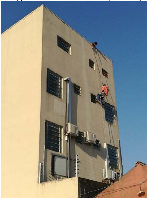
Figura 9 - Fachada Sul (Fundo)
