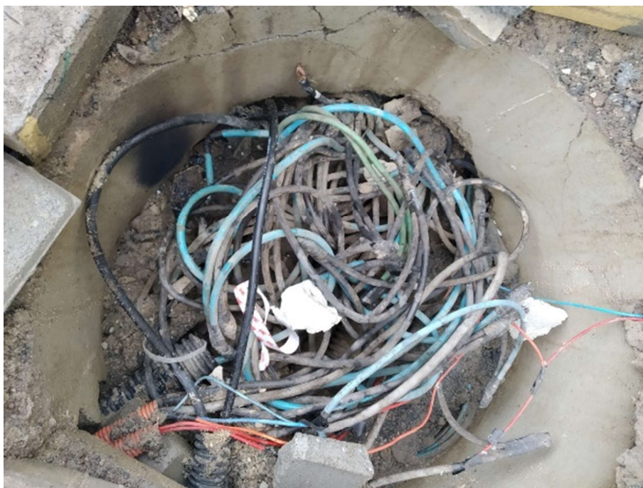
Figura 5 – Fiação exposta
