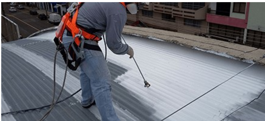
Figura 30:Aplicação de borracha liquida em telhado galvanizado
