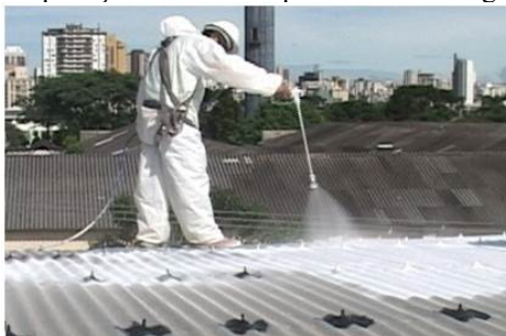
Figura 32: Aplicação de manta líquida em telhado galvanizado
