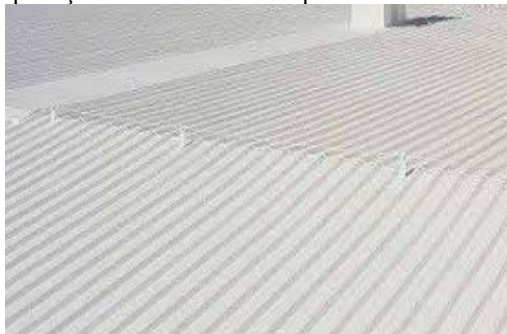
Figura 31: Aplicação de borracha termoplástica em telhado galvanizado
