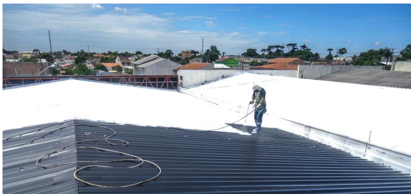
Figura 29: Aplicação de borracha líquida em telhado galvanizado
