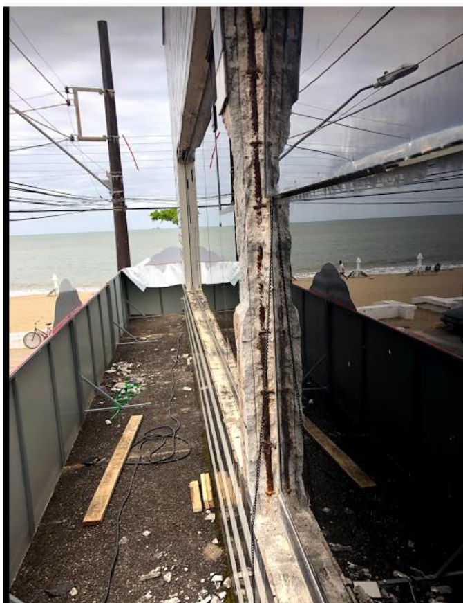
Figura 19. Face superior da marquise (O Autor, 2019).
