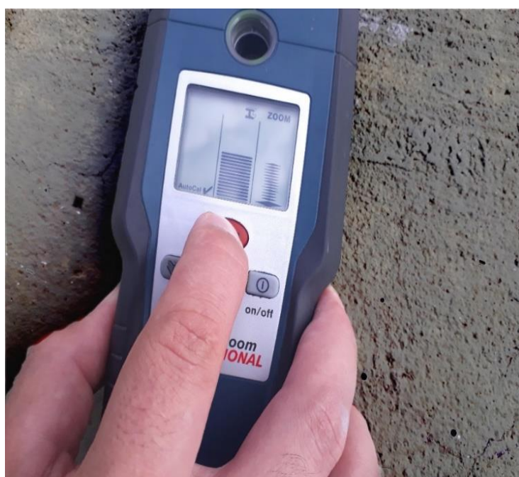
Figura 29. Aplicação do Ensaio de Detecção Magnética de Armaduras (O Autor, 2019).
