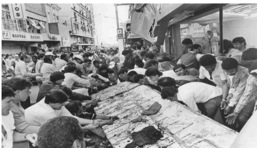
Figura 3. Queda de marquise Loja Arapuã em 1988 (GONÇALVES, 2011).
