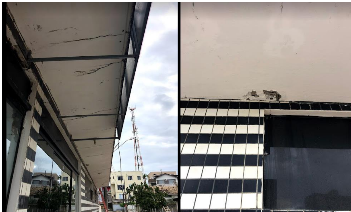
Figura 18. Superfície inferior da Marquise na Fachada Lateral (O Autor, 2019).
