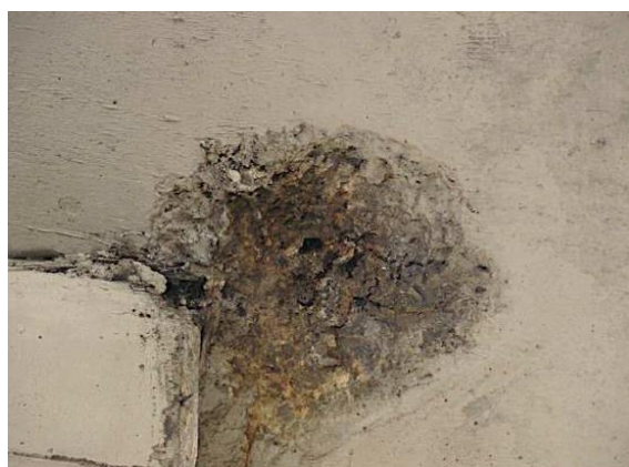
Figura 4: desagregação ( Fi = 2 )
