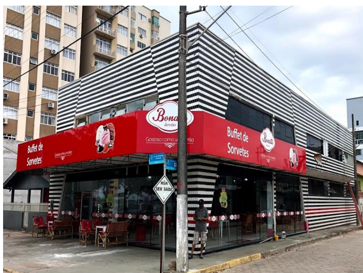
Figura 12. Fachada da edificação escolhida para a Inspeção (O Autor, 2019).
