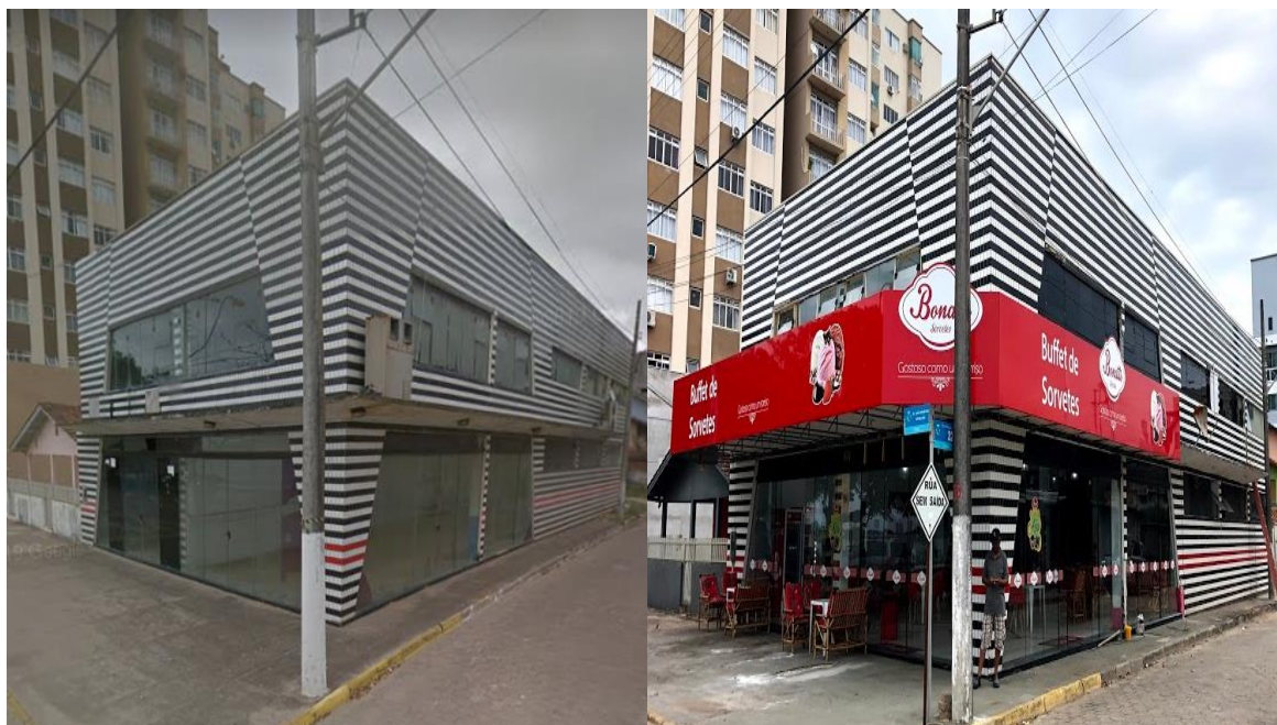
Figura 15. A esquerda a Edificação em janeiro de 2011, a direita em novembro de 2019 (Google Maps, 2011 / o Autor, 2019).
