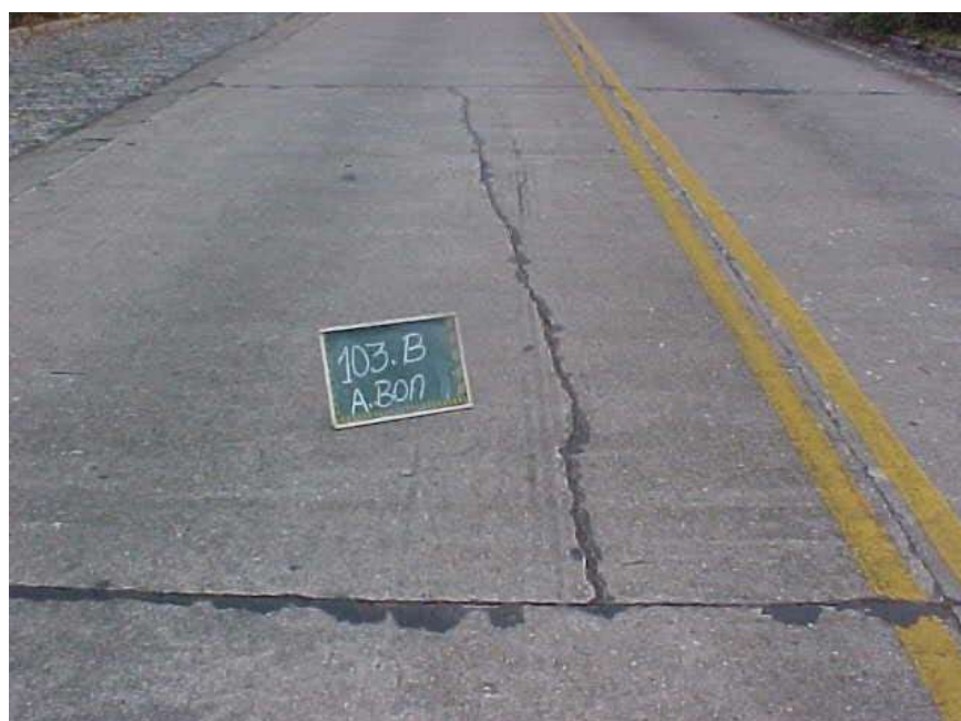
Figura 06: Trincas Longitudinais
