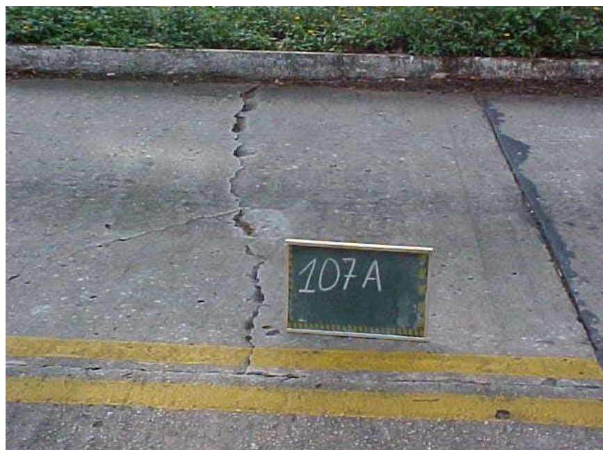
Foto 05: Fissuras Transversais
