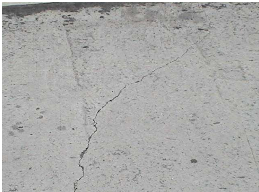
Foto 07: Fissuras Diagonais
