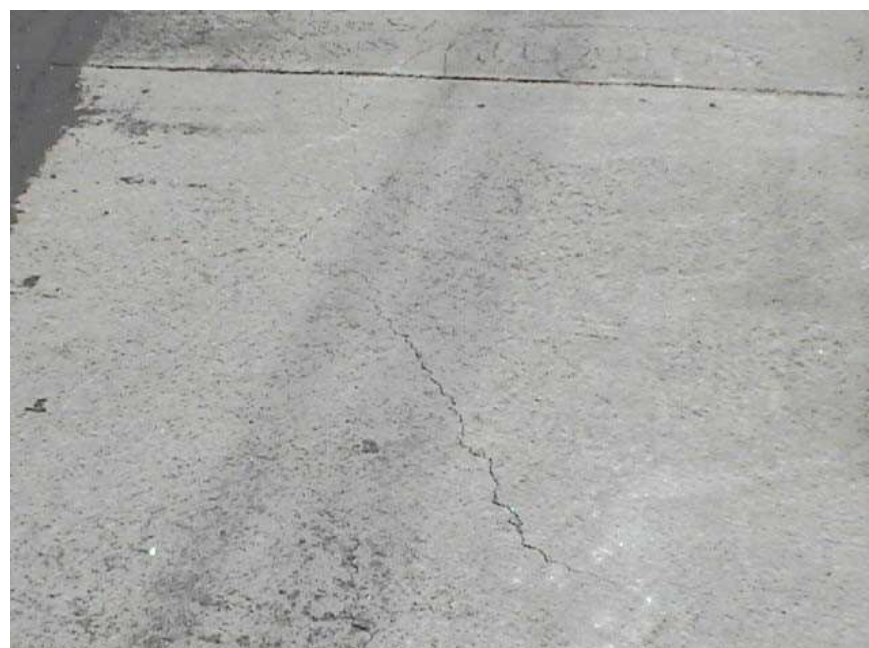
Figura 12: Fissuras Superficiais
