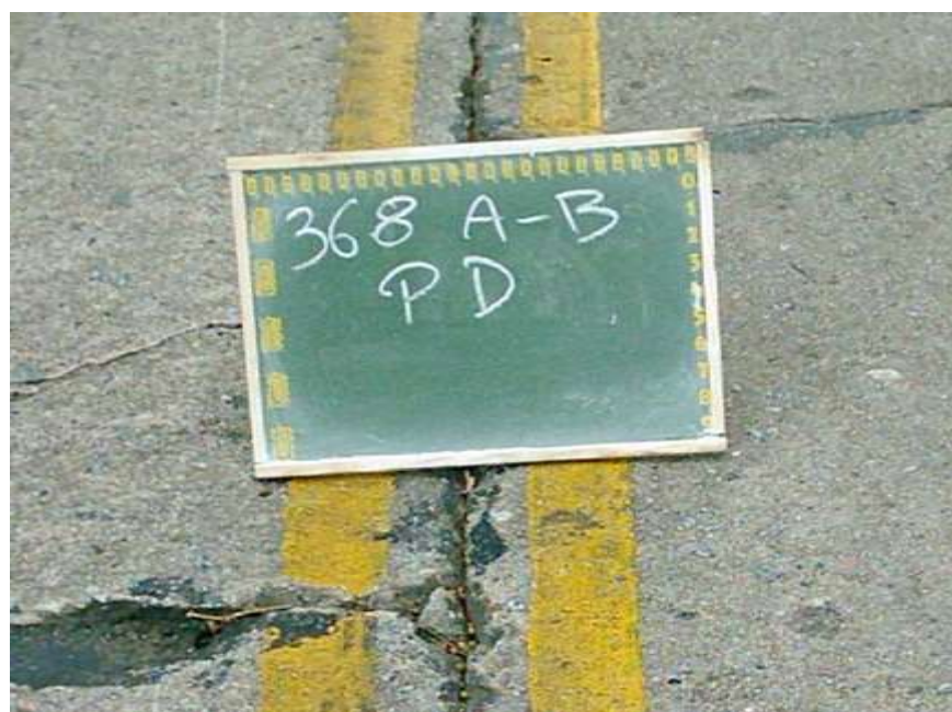
Foto 15: Esborcinamento de Juntas
