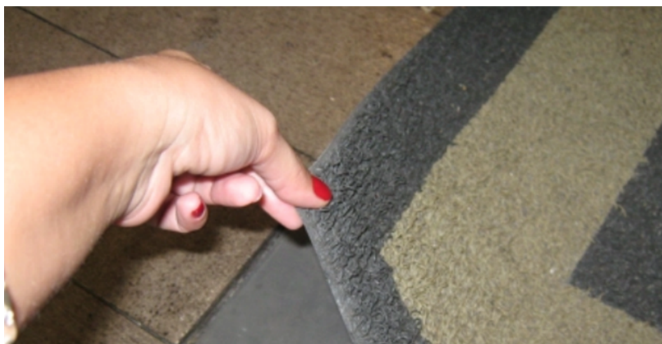
Figura 44. Piso rebaixado para embutir capacho Fonte: FROTA, 2009
