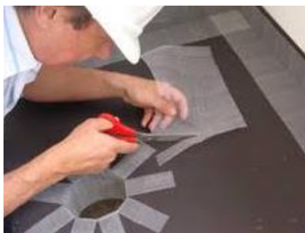
Figura 17 – Impermeabilização de áreas molhadas Fonte: Fibersals, 2017
