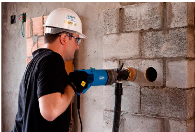
Figura 31 – Furação do bloco de concreto com perfuratriz e serra copo diamantada para fixação de caixinhas elétricas Fonte: Site Grupo Estrutural, 2019
