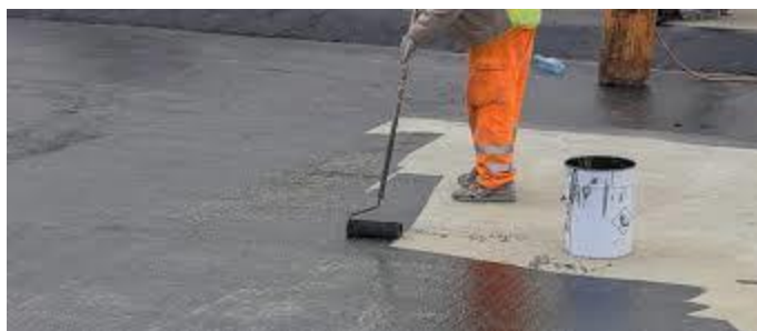
Figura 15 – Aplicação de tinta betuminosa no radier Fonte: Fibersals, 2017
