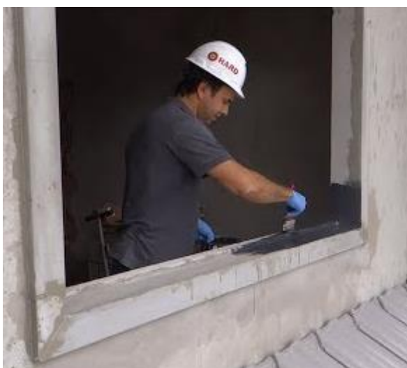
Figura 18 – Impermeabilização no requadro das janelas Fonte: Fibersals, 2017
