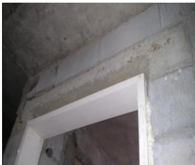
Figura 28 – Verga acima do vão da porta Fonte: Acervo pessoal do autor, 2019
