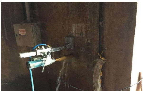
Foto 20 - Extração de testemunho.
