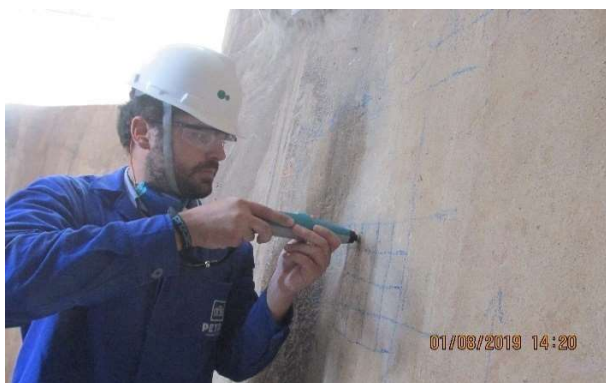
Foto 19 - Realização do ensaio de esclerometria
