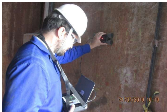
Foto 16 - Ensaio de detecção eletromagnética de armaduras.
