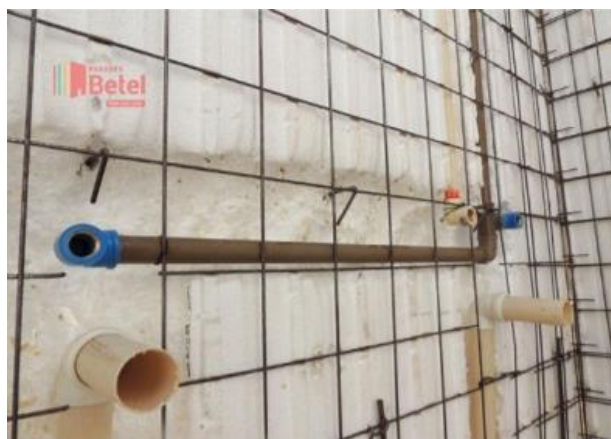
Figura 16 – Passagem de elétrica e hidráulica pelo painel (BETEL, 2018)
