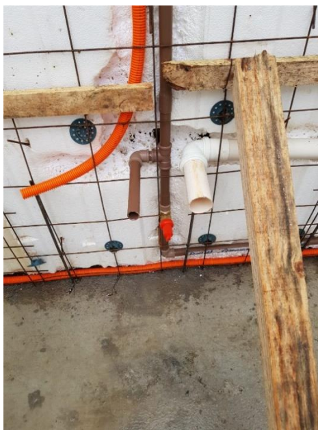
Figura 15 – Passagem de elétrica e hidráulica pelo painel (Calure Engenharia, 2019)
