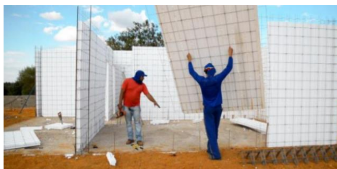
Figura 12 – Colocação do painel (empresa privada, 2018)
