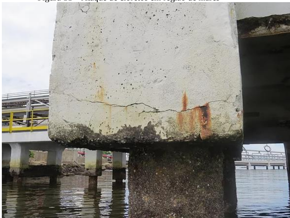
Figura 11 – Ataque de cloretos em região de marés
