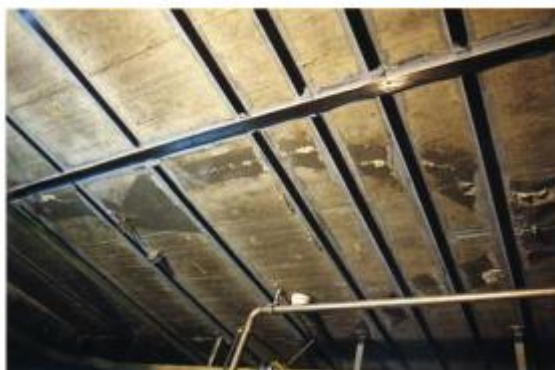
Figura 24 – Reforço com colagem de chapas de aço
