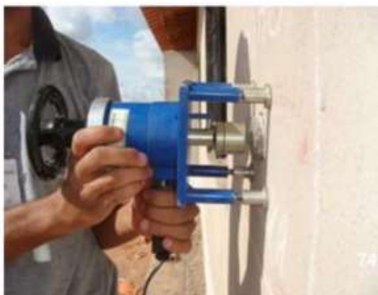
Figura 7 - Execução do ensaio de arrancamento de revestimento de fachada
