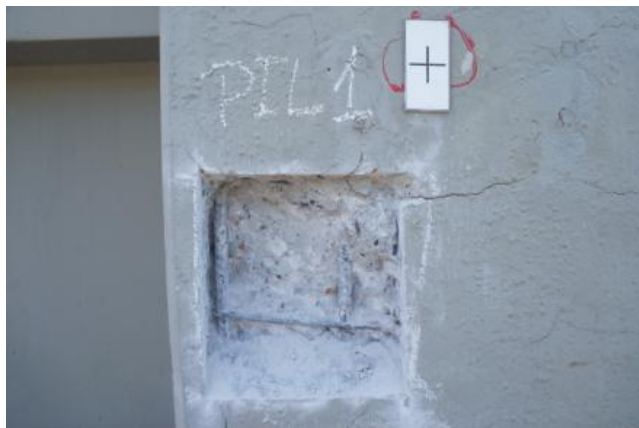
Figura 44. Detalhe de janela de inspeção em pilar pré moldado do AZ01 (AUTOR, 2019).
