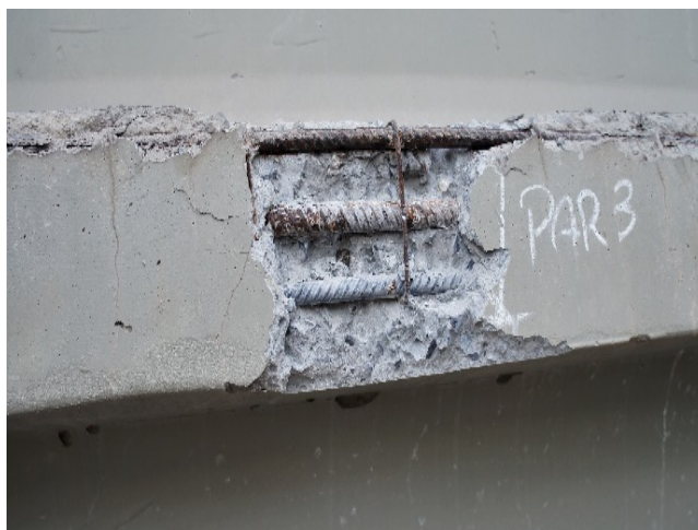
Figura 45. Detalhe de janela de inspeção em painel pré moldado do AZ01 (AUTOR, 2019).
