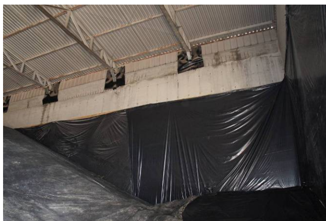
Figura 42. Detalhe de lonas sobre parede e produto estocado no Box 03, do AZ01(AUTOR, 2019).
