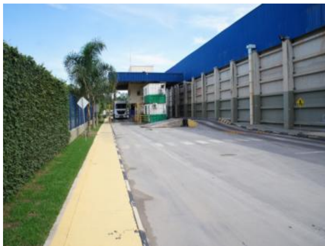
Figura 31. Vista do acesso principal e fachada posterior do AZ01 da construção estudada (AUTOR, 2019).
