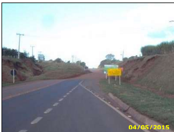
Figura 60 – Limite entre os lotes 2 e 3, Km 124+680.
