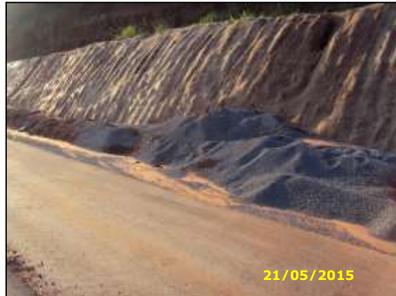
Figura 69 – Resíduo sólido do tratamento superficial simples, km 130+680.
