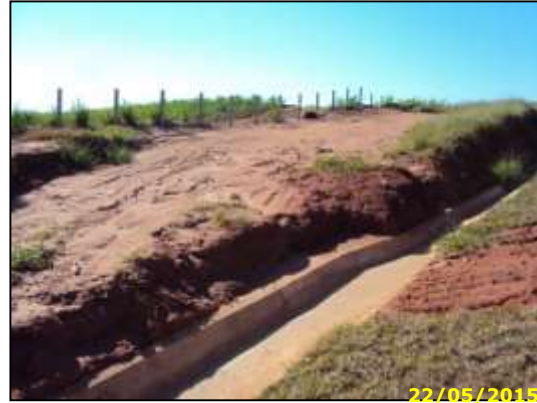
Figura 57 – Caminho de serviço, Km 143+400.
