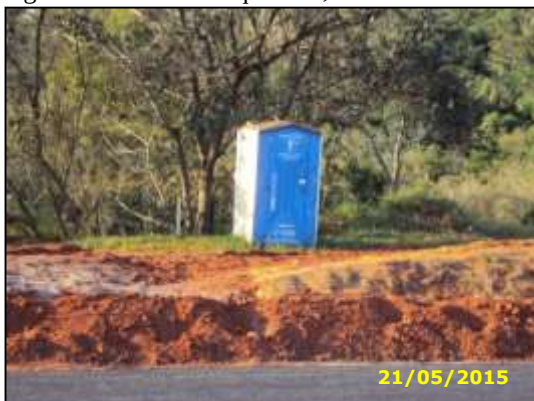
Figura 44 – Banheiro químico, km 129+920.
