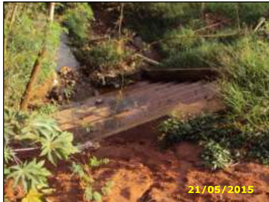
Figura 32 – Córrego próximo ao Km 126+320.
