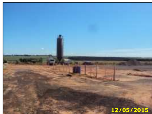
Figura 7 – Pátio do acampamento administrativo, Km 144+780.
