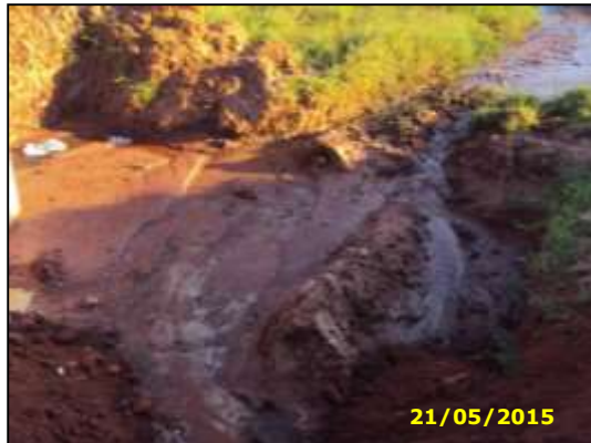
Figura 30 – Córrego junto ao Km 126+520.
