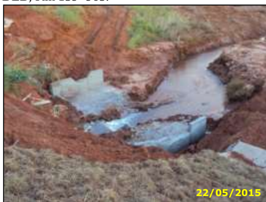
Figura 24 – Remoção de sedimentos do córrego e DEB, Km 139+965.
