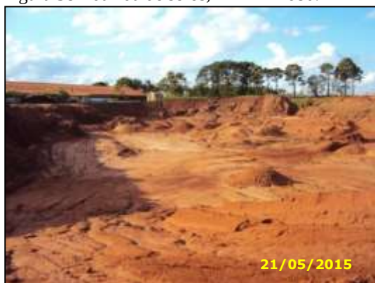
Figura 38 – Jazida de solos, Km 127+680.
