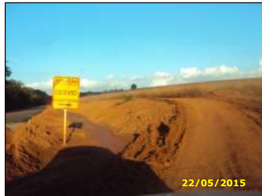
Figura 41 – Caminho de serviço, km 131+340.
