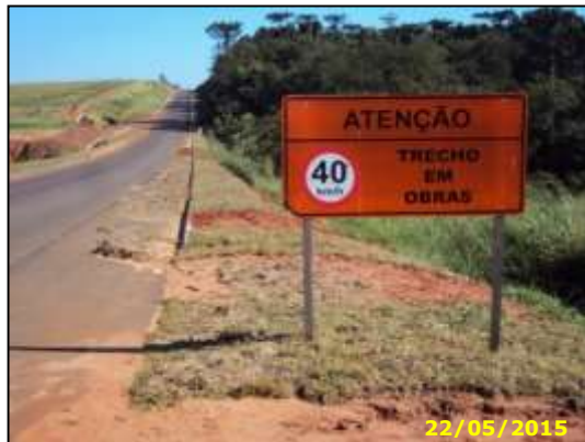
Figura 52 – Sinalização vertical de obras, km 143+400.
