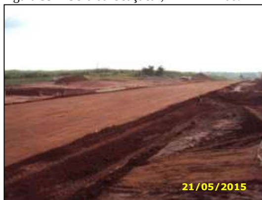
Figura 39 – Obra da Usaçucar, Km 127+700.
