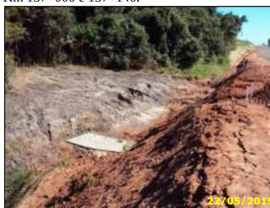
Figura 9 – Demarcação das bacias de contenção, Km 137+000 e 137+140.
