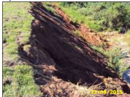
Figura 23 – Talude de aterro e DAD, Córrego Ciquenta e Cinco, Km 142+200.
