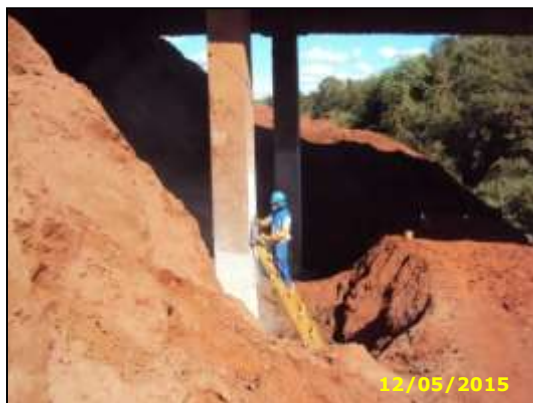
Figura 2 – Obras nos pilares da ponte sobre o Rio Concórdia, Km 130+240.
