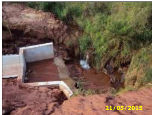
Figura 28 – Dissipador de energia, Córrego junto ao Km 128+840.
