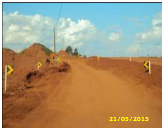
Figura 54 – Sinalização dos locais em obras, km 127+620.
