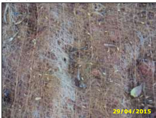
Figura 36 – Hidrossemeadura e biomanta, Km 133+020.
