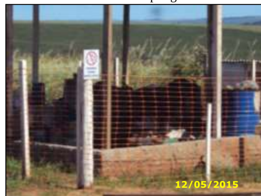
Figura 71 – Sinalização no local de armazenagem de resíduos perigosos.
