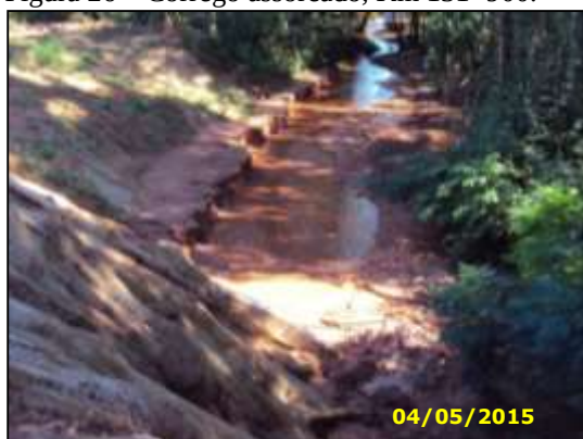
Figura 26 – Córrego assoreado, Km 131+900.
