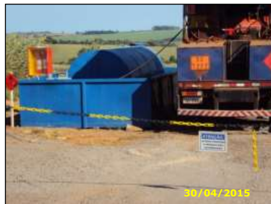
Figura 75 – Isolamento do local de reabastecimento do caminhão comboio.
