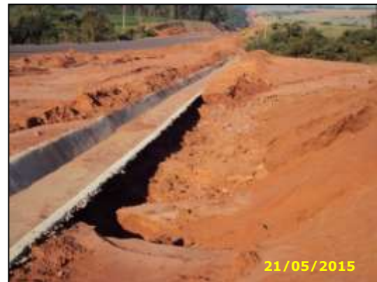
Figura 29 – Solapamento em VPA/DAD, Km 128+800.
