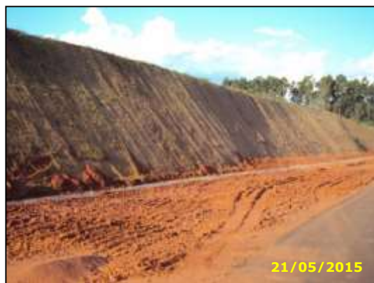
Figura 37 – Talude de corte, Km 129+100.
