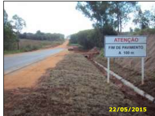
Figura 33 – Enleivamento do solo, Km 126+360.
