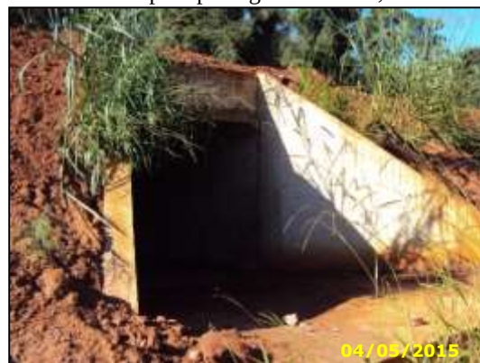
Figura Erro! Nenhum texto com o estilo especificado foi encontrado no documento..17 – Bueiro celular para passagem de fauna, Km 137+140.
