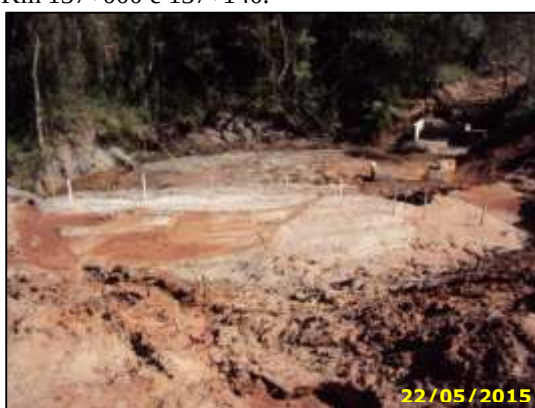
Figura 8 – Demarcação das bacias de contenção, Km 137+000 e 137+140.
