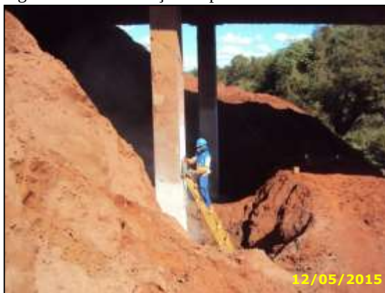
Figura 48 – Restauração de pilar sob OAE.
