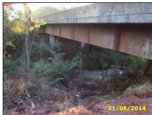
Figura 5 – OAE sobre o Rio Mouro, Km 131+300.
