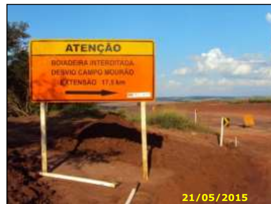
Figura 55 – Sinalização em desvio, Km 127+700.
