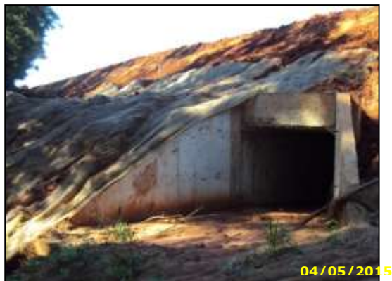
Figura Erro! Nenhum texto com o estilo especificado foi encontrado no documento..14 – Bueiro celular de talvegue e passagem de fauna, Km 131+930.
