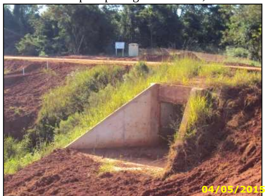
Figura Erro! Nenhum texto com o estilo especificado foi encontrado no documento..16 – Bueiro celular para passagem de fauna, Km 135+440.
