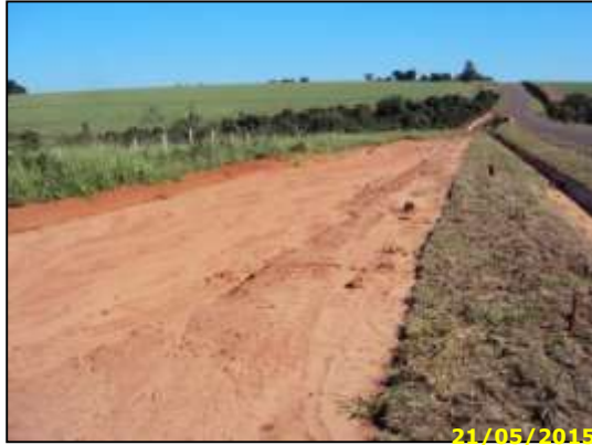
Figura 56 – Caminho de serviço, Km 142+480.
