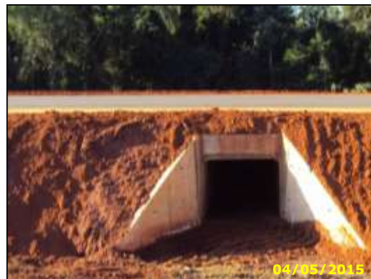
Figura Erro! Nenhum texto com o estilo especificado foi encontrado no documento..15 – Bueiro para passagem de fauna, Km 134+455.
