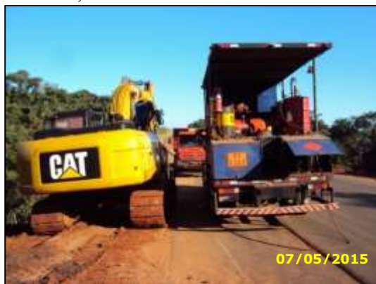
Figura 72 – Reabastecimento de escavadeira hidráulica, km 137+140.
