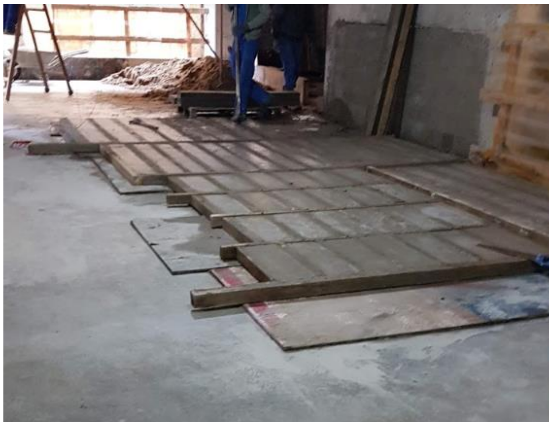
Figura 102 - Fabricação vergas e contravergas pré-moldadas obra Fonte: Contrutora A.Yoshii (2018)
