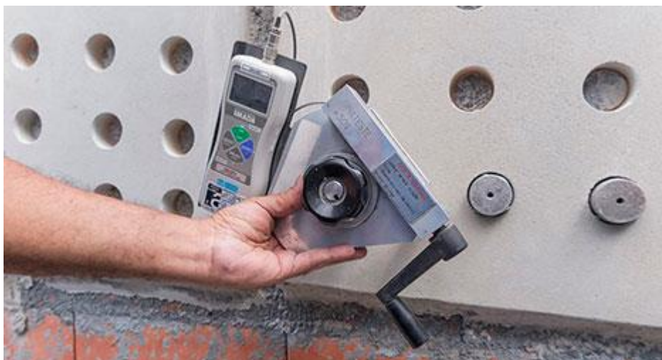
Figura 41 - Teste de Arrancamento
