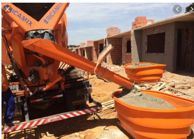
Figura 91 - Descarregamento Argamassa Estabilizada
