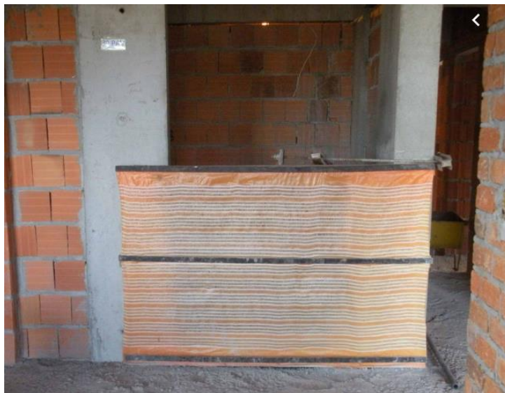
Figura 36 - Sistema de Guarda Corpo Fonte: https://www.ufrgs.br/eso/content/?p=523
