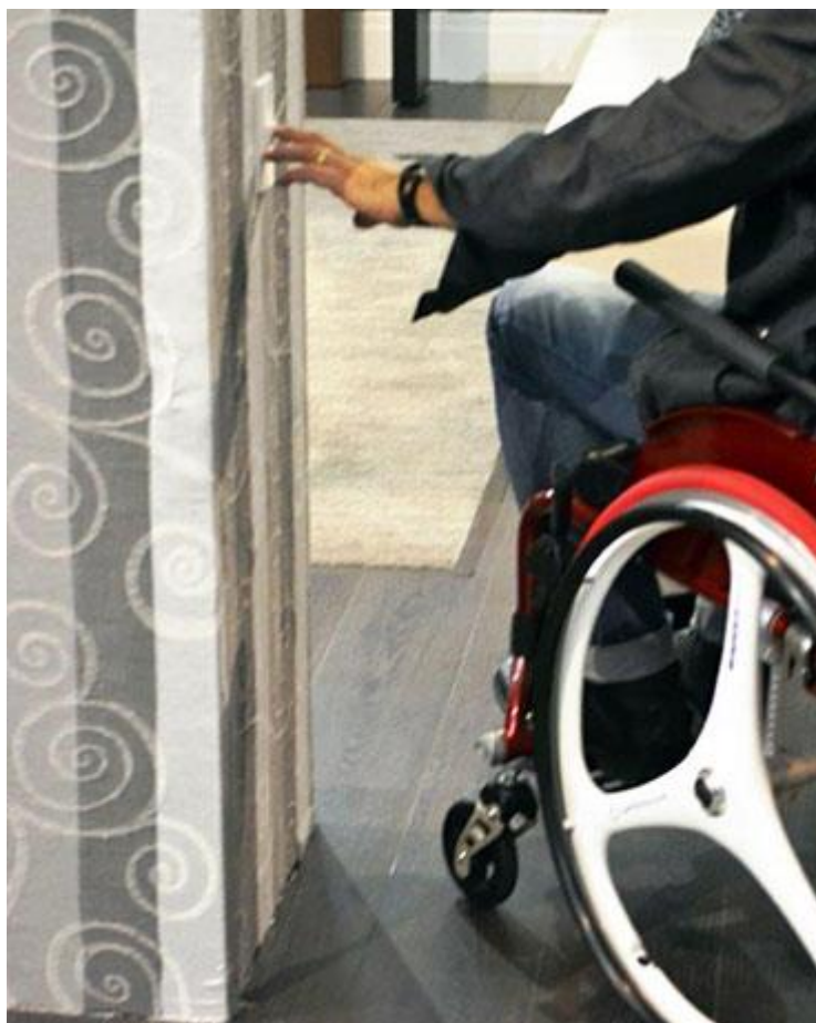
Figura 115 - Interruptor c/ altura acessível
