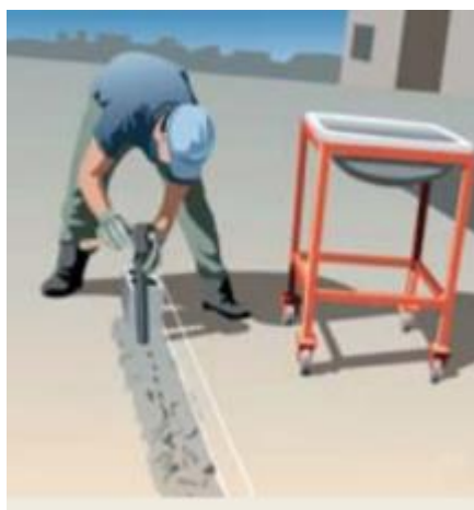
Figura 93 - Assentamento primeira fiada
