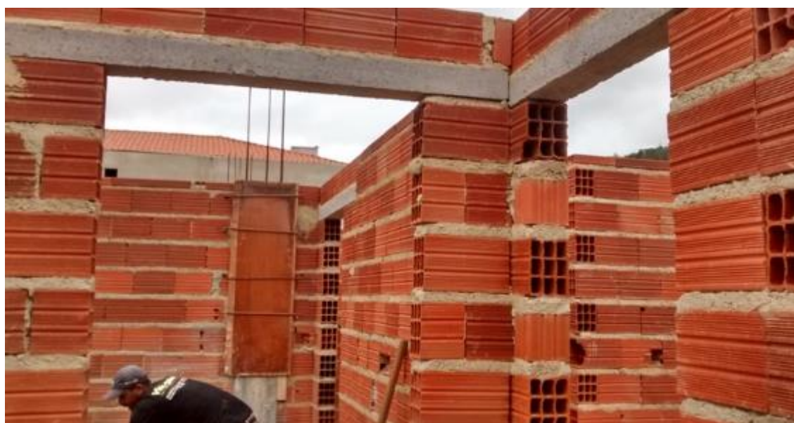
Figura 103 - Verga Instalada
