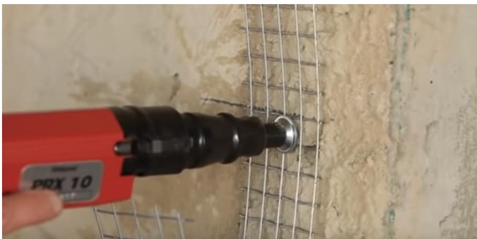
Figura 99 - Fixação da tela de amarração Fonte: http://www.comercialiso.com.br/aplicacoes
