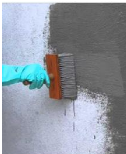
Figura 46 - Aplicação argamassa polimérica com trincha Fonte: https://ecoengenharia.com.br/produto.asp?PID=53
