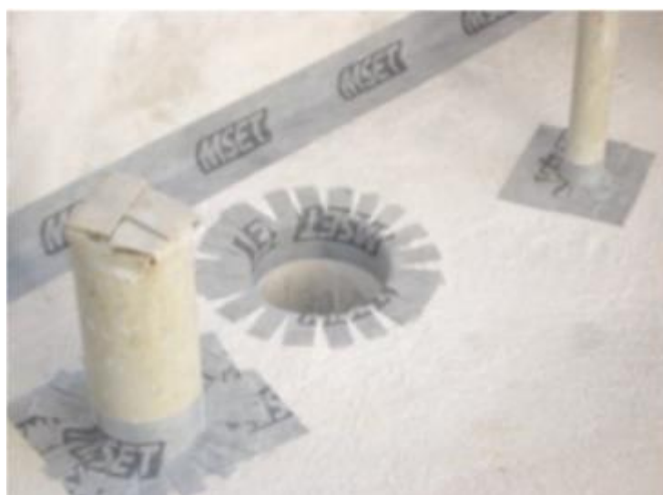
Figura 44 - Reforço Ralos e Tubulações
