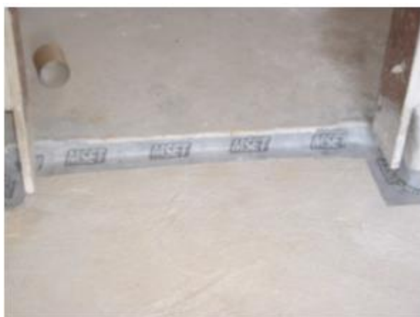
Figura 45 - Reforço com tela de PVC Fonte: http://www.impertela.com.br/aplicacao.html
