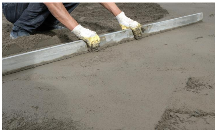
Figura 34 - Sarrafeamento do contrapiso
