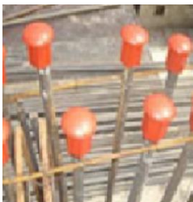
Figura 55. Proteção de Vergalhões (CBIC, 2017)
