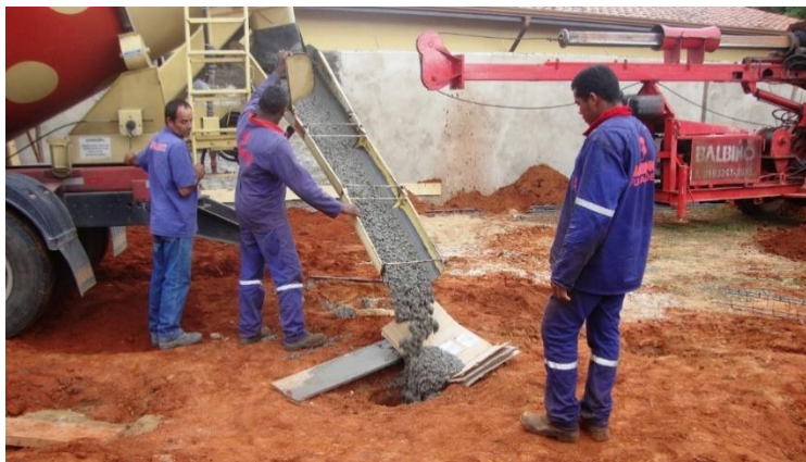
Figura 57. Exemplo de concretagem de estacas (SP NOSSA CASA, 2015)
