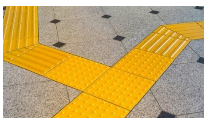
Figura 5. Sinalização por piso tátil (WATPLAST, 2019).
