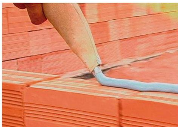
Figura 70. Aplicação de argamassa polimérica para assentamento de tijolos (SILVA AT AL, 2015).
