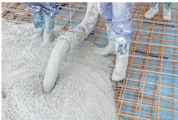
Figura 60. Concretagem de laje com utilização de caminhão lança (BELGO BEKAERT ARAMES, 2019.)
