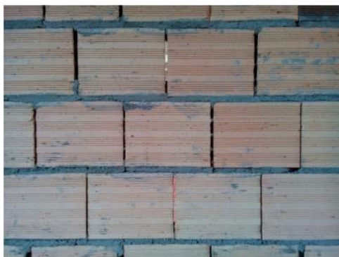
Figura 71. Tijolo assentado com junta seca (FORNER, 2015).
