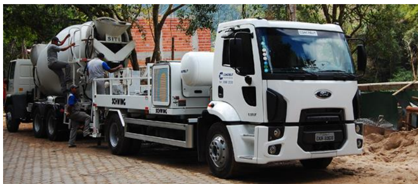
Figura 58. Exemplo de disposição de caminhão bomba lança e caminhão de concreto na obra (CONCRELIT, 2019)
