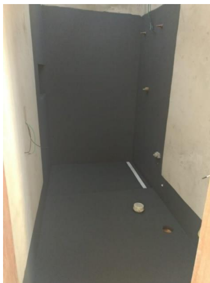
Figura 65. Impermeabilização de banheiro (VR IMPERMEABILIZAÇÕES, 2019)
