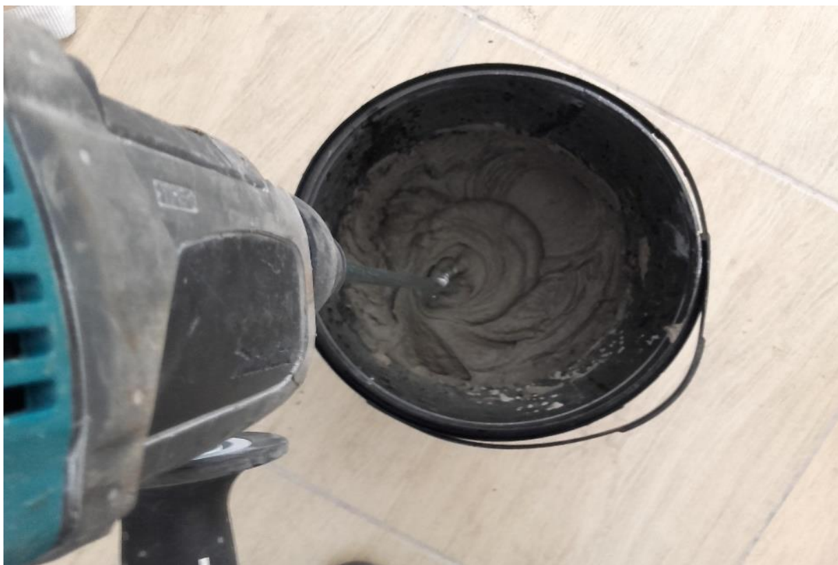
Figura 20- Mistura da Argamassacolante ACII- Autor.
