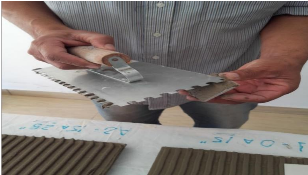
Figura 23. Argamassa no Tardoz.
