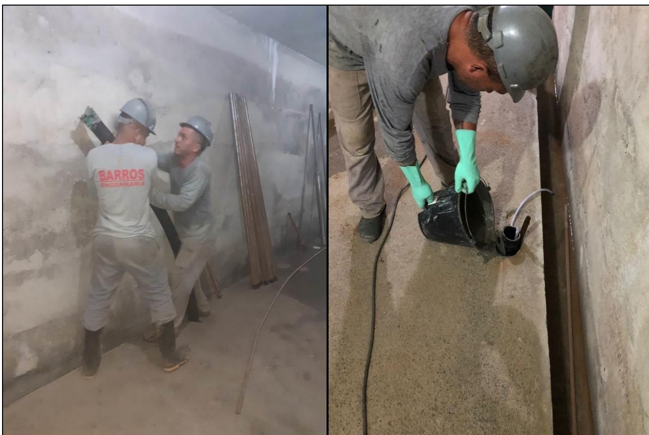
Figura 17 - Inserção do revestimento do concreto e lançamento de calda de cimento para seu chumbamento e para a consolidação do concreto do entorno.
