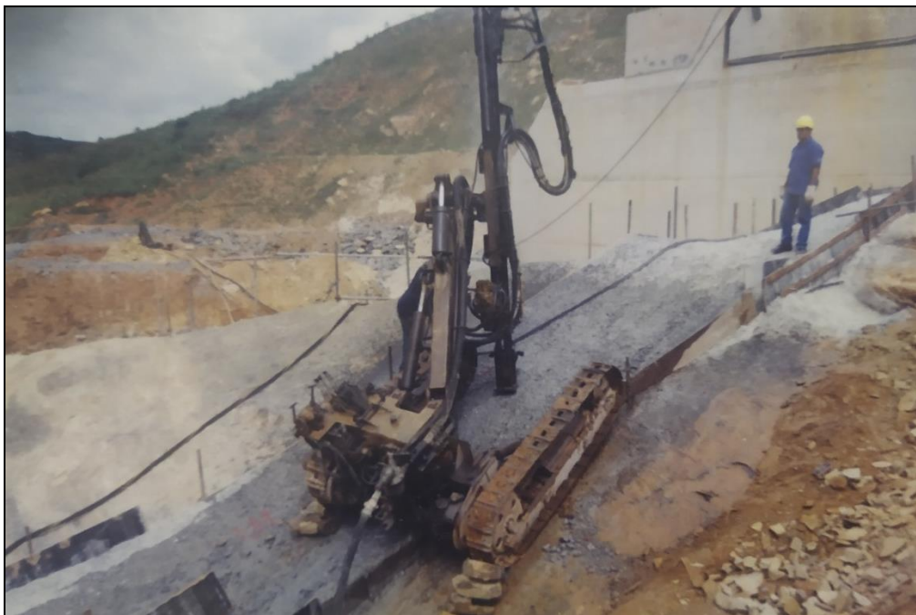
Figura 6 - Perfuração dos drenos de fundação, conformados pela meia cana.
