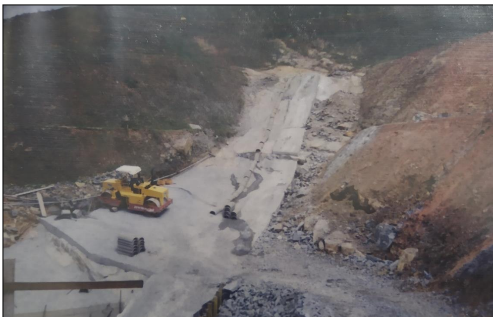
Figura 7 - Execução da meia cana ao longo da ombreira direita.
