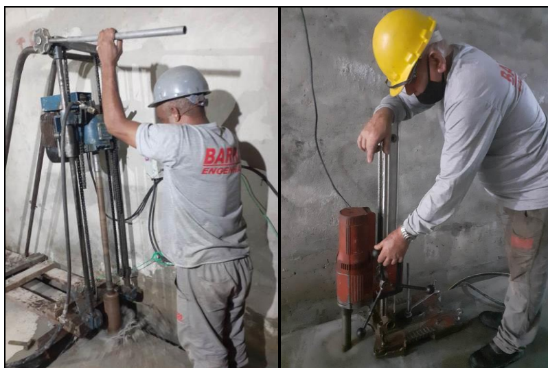
Figura 12 - Sonda JKSMIT&SONS adaptada (à esquerda) e Hilt DD200 (à direita)
