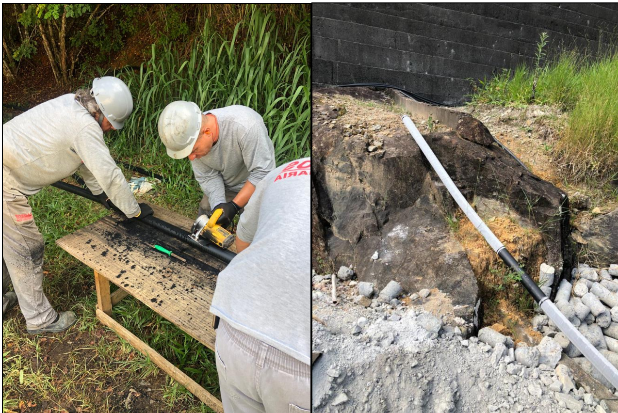
Figura 18 - Confecção das aberturas do tubo e instalação de malha ASTM 60micra – Revestimento do trecho da fundação para a proteção da rocha.
