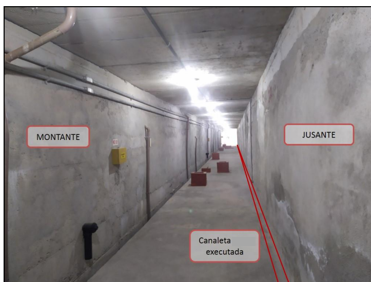
Figura 10 - Canaleta executada antes do início da execução dos drenos.
