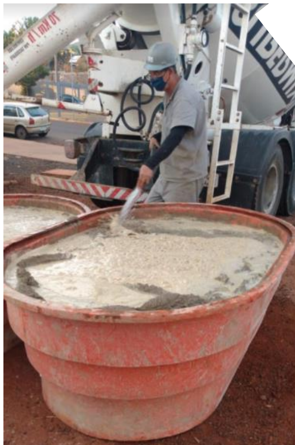
Figura 31 - Colocação de lâmina d'água no material armazenado. Fonte: autores, 2020.
