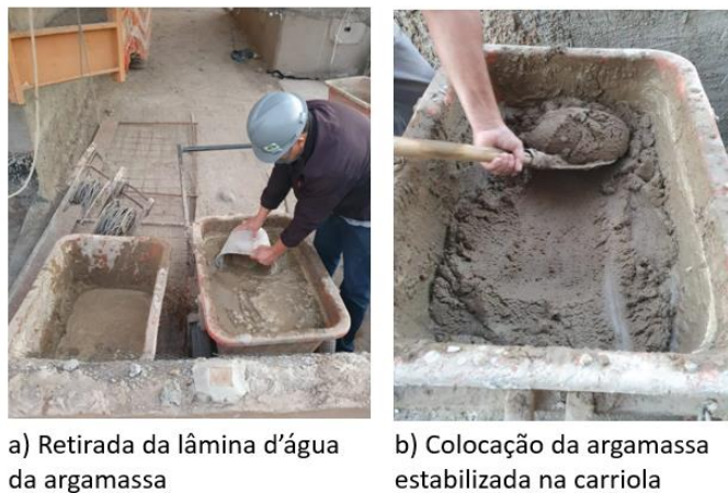
Figura 32 – Preparo da argamassa para utilização. Fonte: autores, 2020
