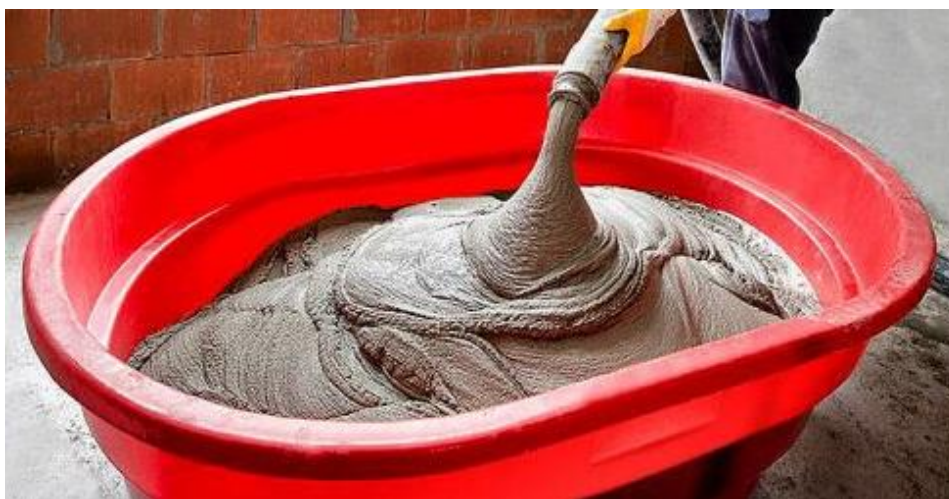
Figura 1 - Caixa para armazenamento da argamassa estabilizada Fonte: Google imagens
