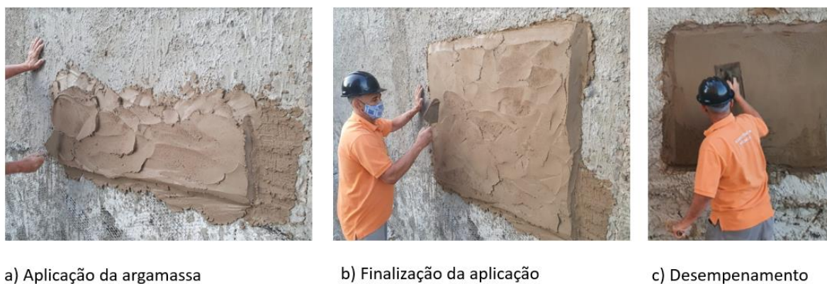
Figura 33 - Aplicação da argamassa sobre muro chapiscado para execução do pano teste Fonte: autores, 2020
