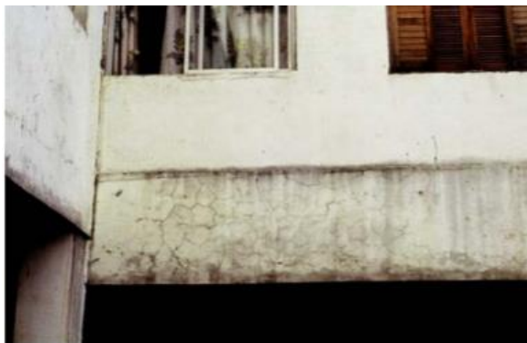
Figura 25 - Fissuras de retração em concreto armado, causadas pela elevadíssima quantidade de cimento e/ou relação água cimento do concreto
