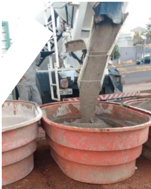
Figura 30 - Recebimento e armazenamento da argamassa estabilizada de 36h. Fonte: autores, 2020.
