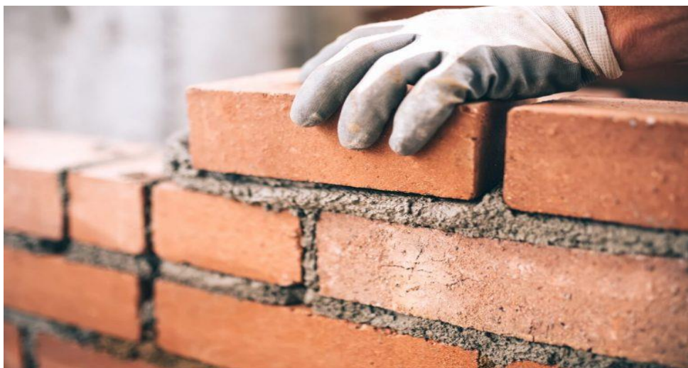
Figura 6 - Argamassa de assentamento de blocos e tijolos Fonte: (FIDA NOTÍCIAS, 2019).
