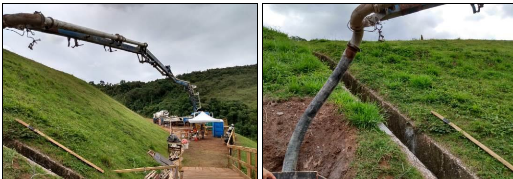
Figura 15: Execução da concretagem inicial
