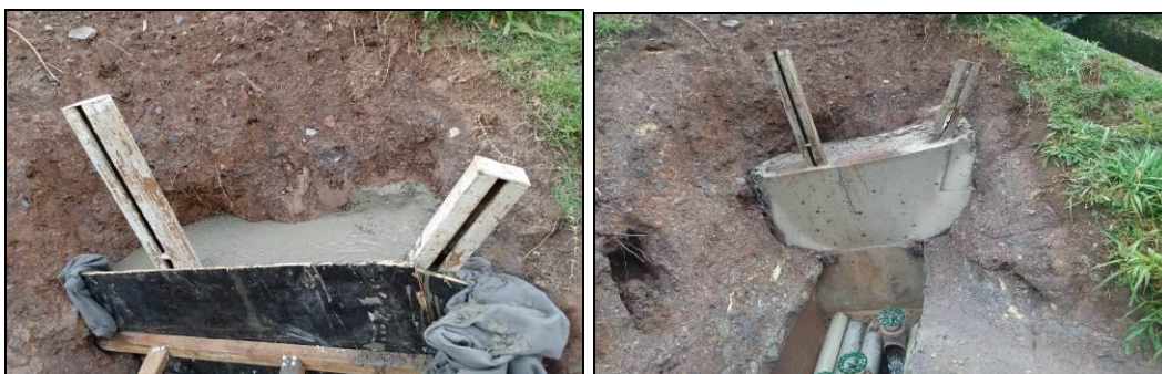
Figura 16: Concretagem realizada para tamponamento no desemboque
