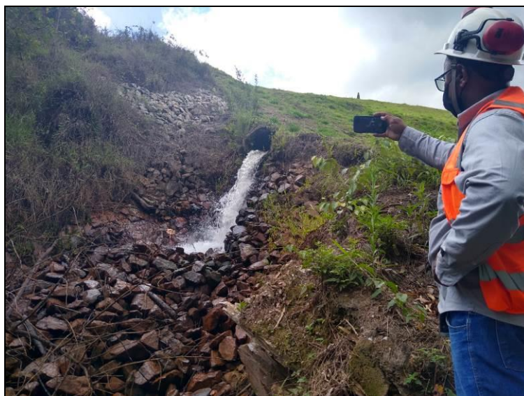
Figura 2: Desemboque da galeria antes da construção do acesso
