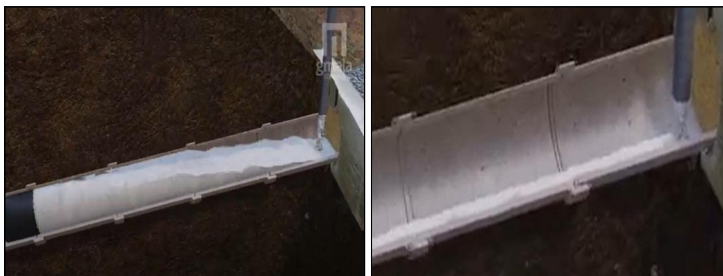
Figura 5: Concretagem plug a montante
