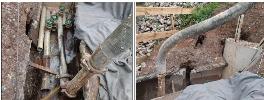
Figura 20: Desemboque galeria – Bombeamento com concreto subaquático
