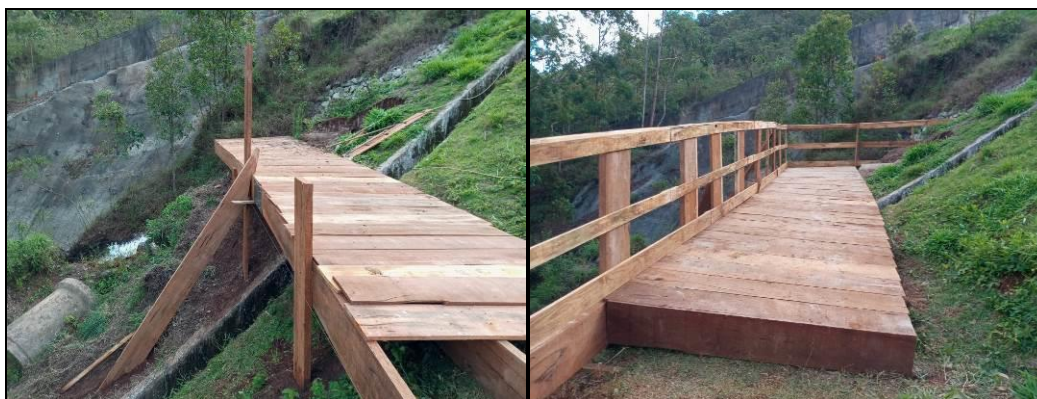
Figura 3: Execução da passarela de acesso
