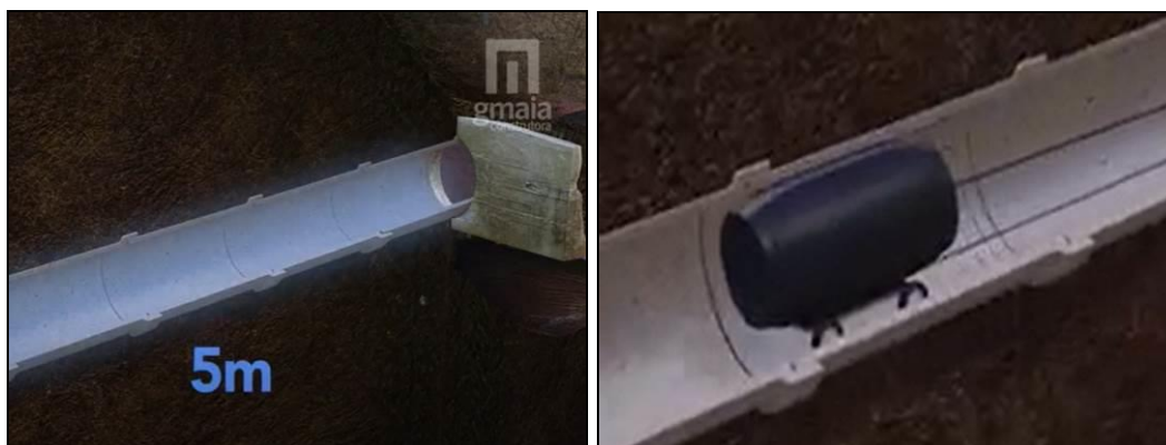
Figura 4: Área de concretagem e inserção do balão inflável (forma)
