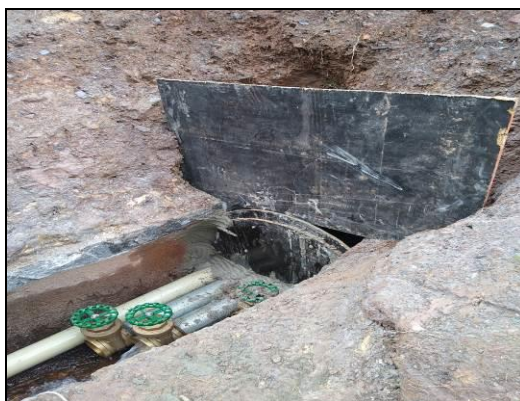
Figura 14: Execução de forma no desemboque para tamponamento
