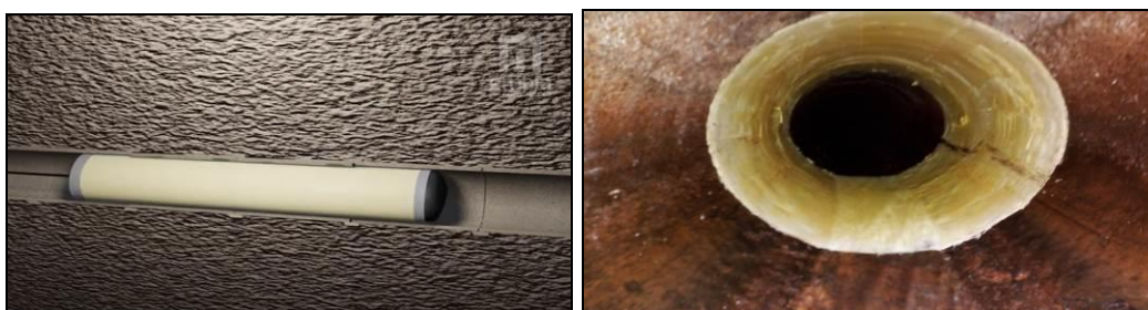
Figura 8: Desemboque galeria – Procedimento CIPP
