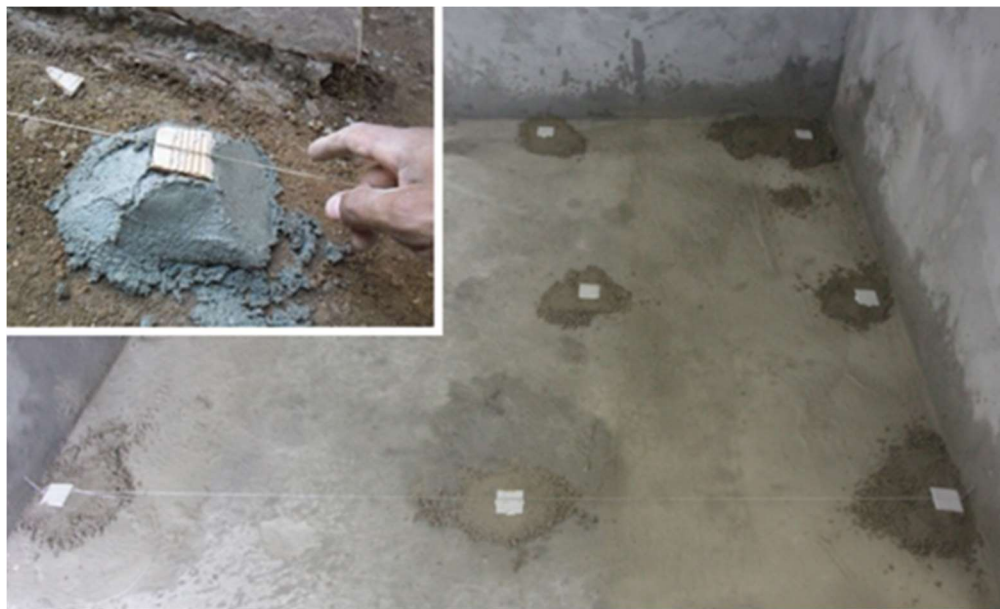
Figura 31 - Como fazer um contrapiso que será revestido com cimento queimado (Microreve, 2021)
