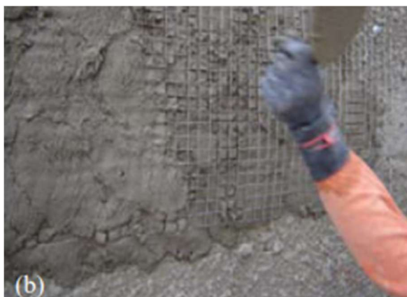
Figura 16 - Telas metálicas de reforço instaladas junto ao reboco (Antunes, 2016)
