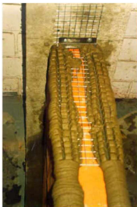
Figura 14 - Tela metálica fixada com pinos de revólver elétrico na ligação pilar-alvenaria (Tramontin, 2005)
