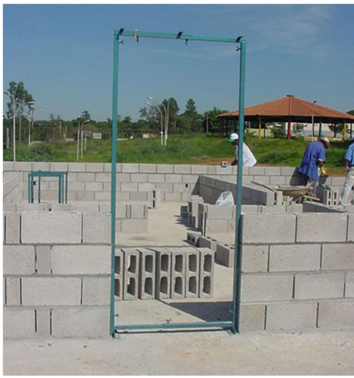
Figura 30 - Gabarito para vão de Porta (Equipaobra, 2021)
