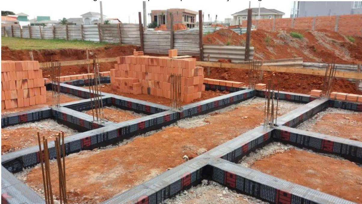
Figura 14 - Exemplo de impermeabilização de vigas baldrame
