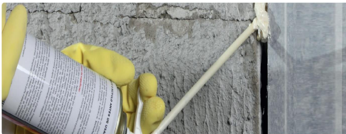
Figura 11 - Exemplo de colocação de poliuretano em portas
