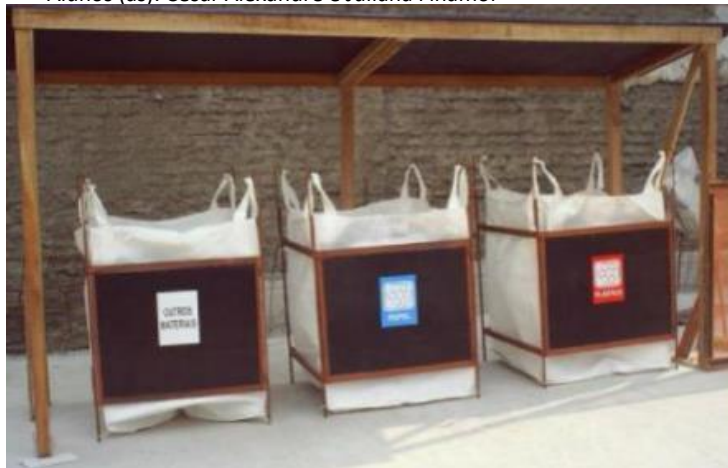
Figura 3 – Exemplo de acondicionamento de resíduos em baias.
